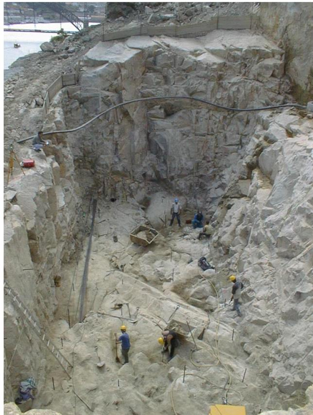
Fig. 5 – Diaclases no maciço granítico de fundação de uma ponte (adaptado de Geologia de Engenharia 2014)
