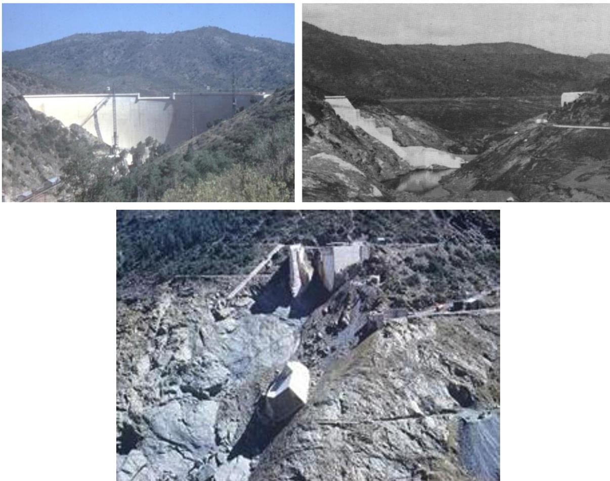
Fig. 1 - Fotografias da barragem de Malpasset antes e depois da rotura e da margem esquerda em que são bem visíveis os planos de descontinuidade por onde se deu a rotura (adaptado de Duffaut 2013)
