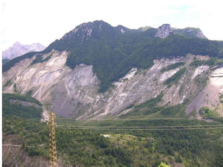
Fig. 2 - Vista da cicatriz da rotura da encosta do reservatório da barragem de Vajont (adaptado de [http://en.wikipedia.org/wiki/Vajont\\_Dam](http://en.wikipedia.org/wiki/Vajont_Dam))
