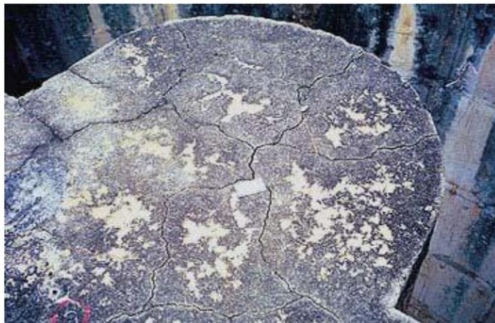
Figura 3.14 – Topo de pilar de descarregador de barragem afetado por ASR [37].
