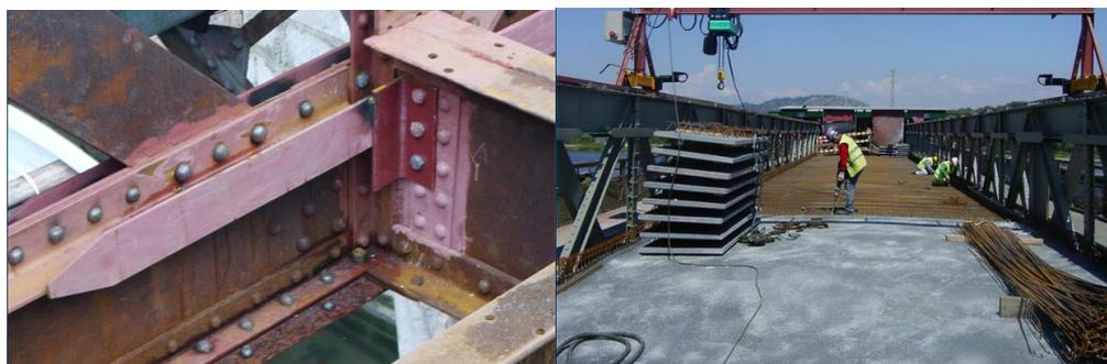
Figura 3.3 – a) Estado de degradação do material b) trabalhos de Reabilitação da Ponte de Fão [68]
