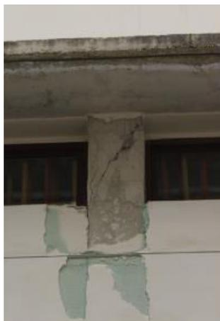
Figura 2.2. Mecanismo do tipo pilar-curto [19].
