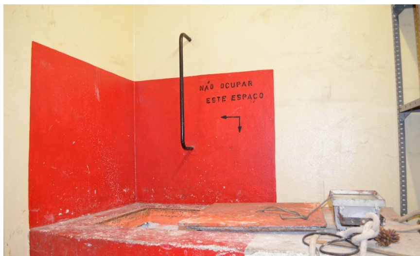
Fig. 4.12 – Entrada para a cisterna.
