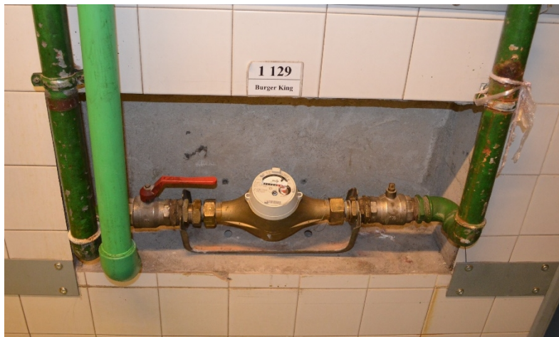
Fig. 4.24 – Contador de espaço comercial.
