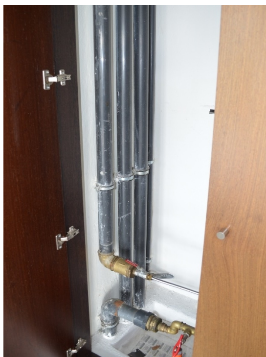
Fig. 4.48 – Coluna montante.
