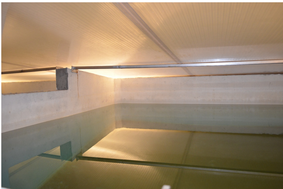
Fig. 4.59 – Interior da cisterna.
