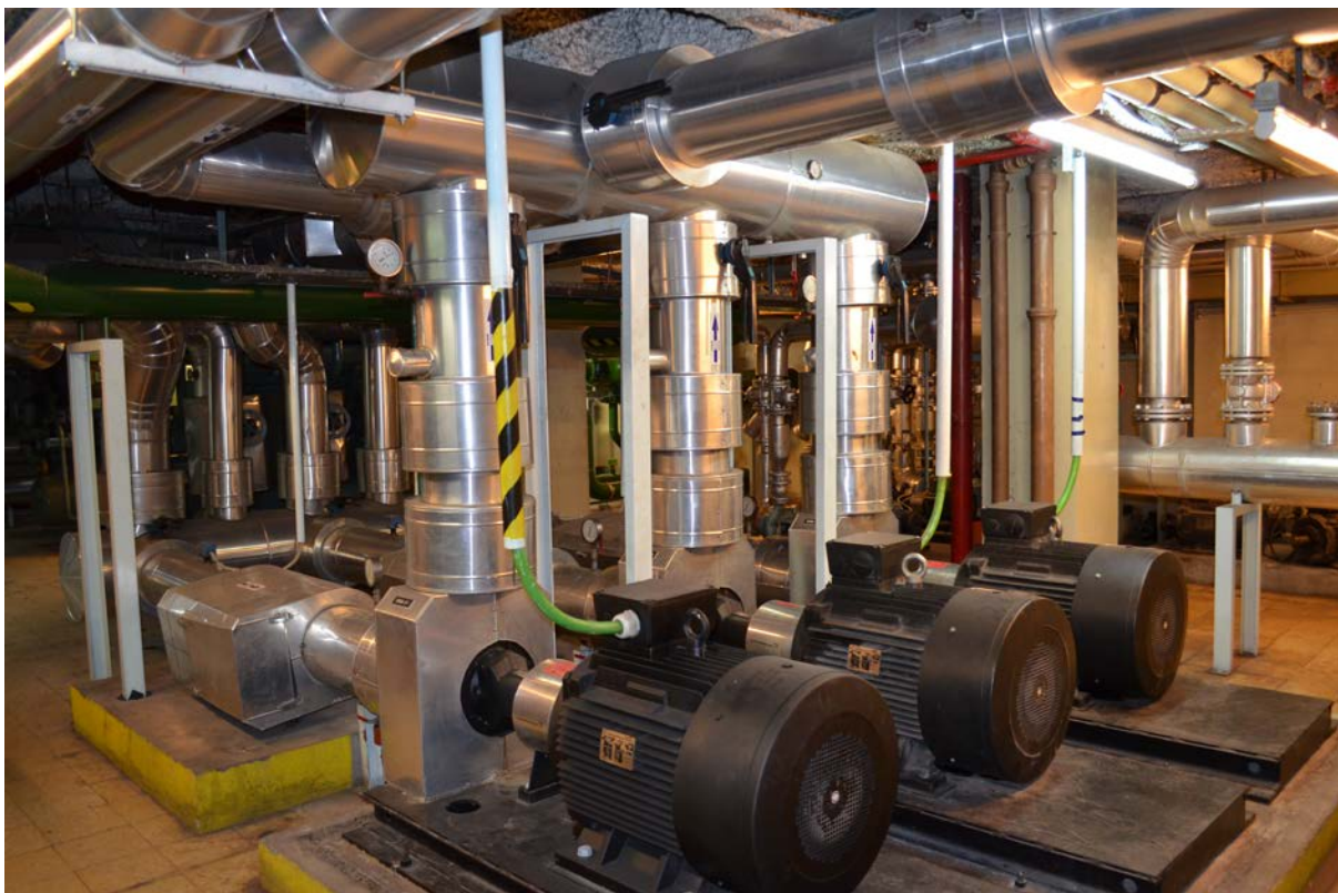
Fig. 4.10 – Grupos hidropneumáticos.
