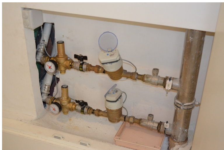
Fig. 4.54 – Espaço técnico para contadores.
