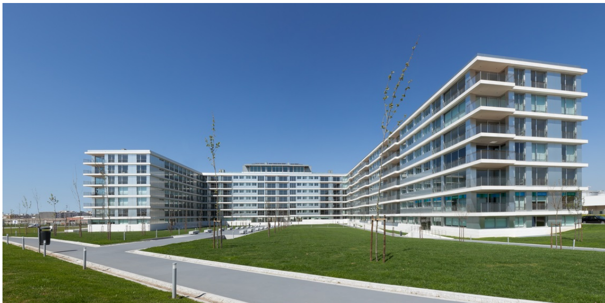
Fig. 4.53 – Edifício do Parque. [42]
