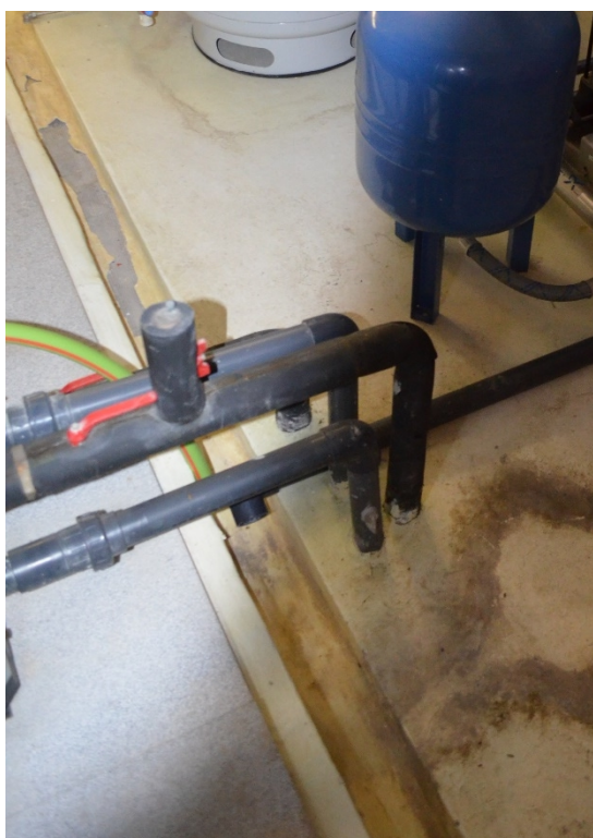
Fig. 4.52 – Drenagem do espaço técnico.
