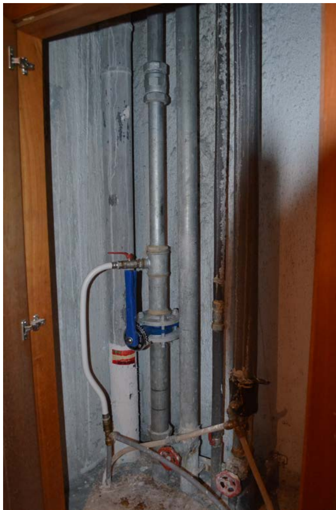
Fig. 4.17 – Exemplo de corete entre dois quartos.
