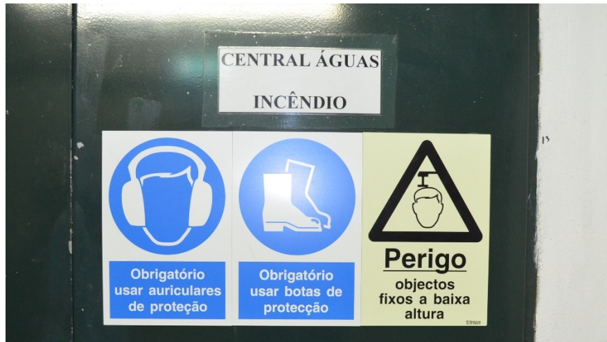
Fig. 4.35 – Central de Incêndio e cisternas.
