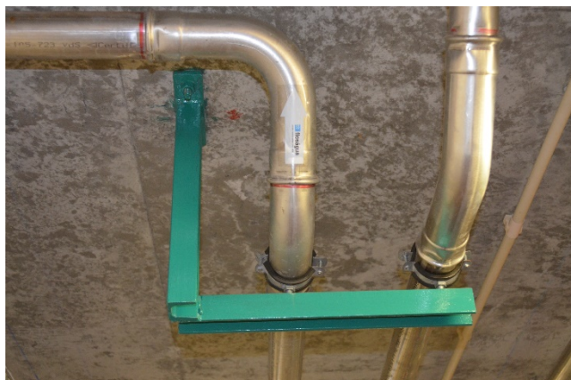
Fig. 4.41 – Perfis de fixação das tubagens.
