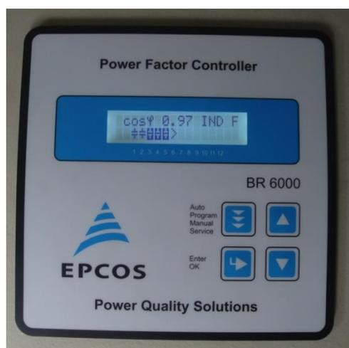
Figura 4-2: Controlador do fator de potência instalado na bateria de condensadores do PT1
