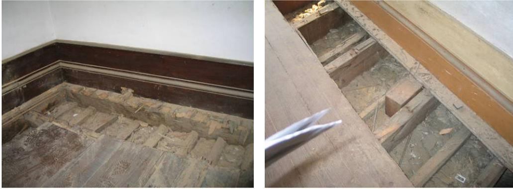
Figura 18: Remoção do soalho no perímetro dos compartimentos para visualização das entregas das vigas
