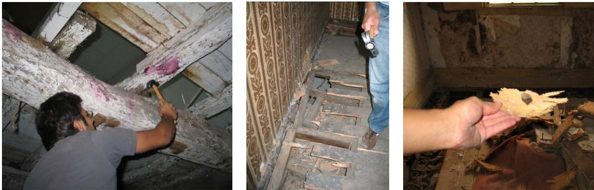
Figura 19: Inspeção efectuada nos pavimentos de madeira, através da utilização de martelo e formão
