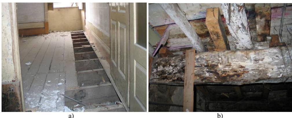
Figura 22: Estado de conservação das vigas do pavimento: a) elementos em bom estado; b) elementos com degradações pontuais
