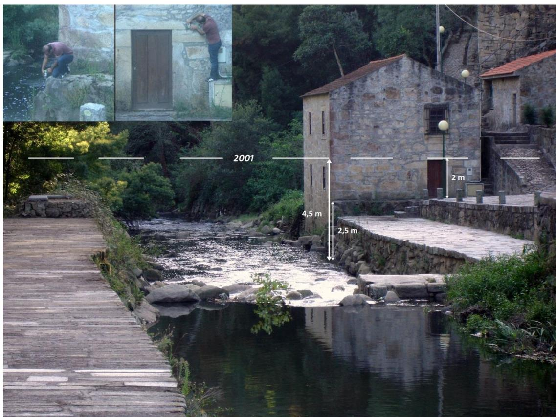
Figura 37 – Medições efetuadas à possível altura da coluna de água no moinho localizado no sector da Ponte do Carro em Santa Cruz do Bispo.
