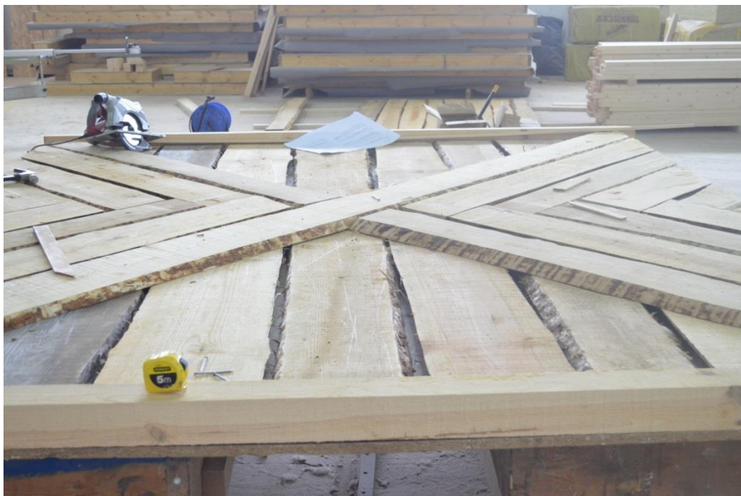
Fig.5.13 – Construção da Parede de Tabique Dupla
