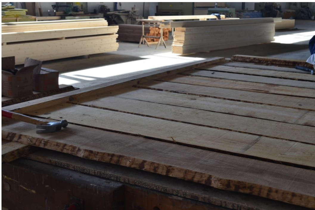
Fig.5.9 – Parede de Tabique Simples sem ripado
