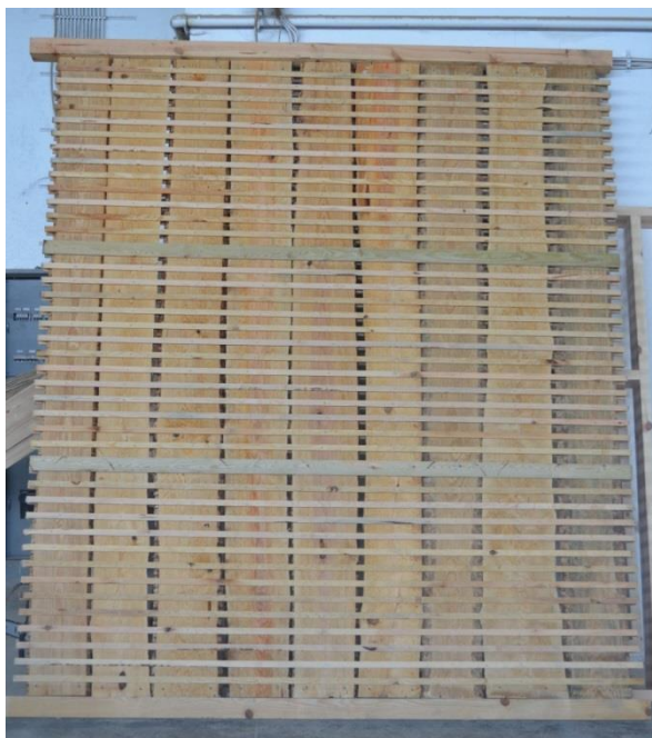
Fig.5.11 – Parede de Tabique Simples concluída
