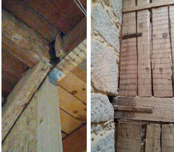
Fig.2.9 – Ligações metálicas em paredes de tabique (edifício na rua da Foz)
