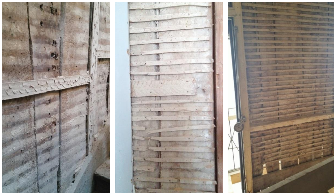
Fig.2.4 – Paredes de tabique simples do edifício da rua de Cedofeita – pormenor das ripas
