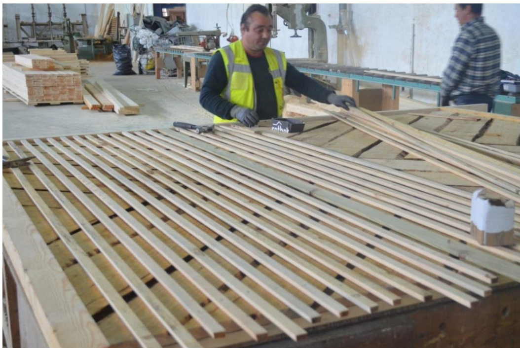
Fig.5.15 – Parede de Tabique Dupla com ripado
