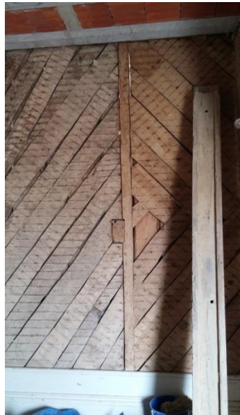
Fig.2.7 – Paredes de tabique duplo (edifício na Foz)
