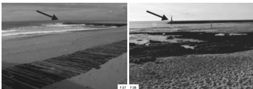
FIGURA 7: PRAIA DE CANIDELO (2008) – ENROCAMENTO (PROTEGE O EXUTOR); FIGURA 8: PRAIA DA AGUDA (2008) – QUEBRA-MAR.
