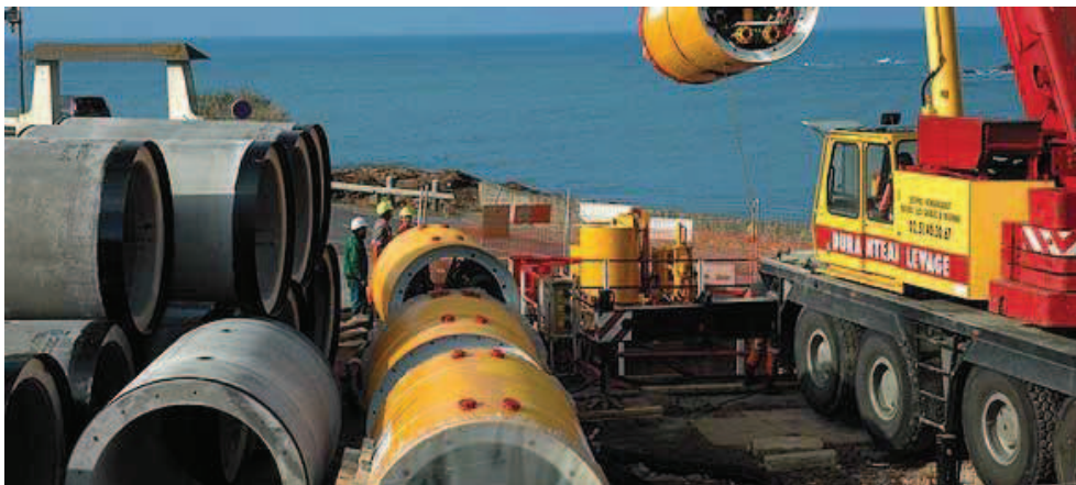
Fig. 3.46 – Exemplo de uma zona de armazenamento e manuseamento dos tubos a colocar no poço de ataque (Herrenknecht 2011)
