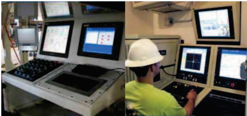
Fig. 3.35 - Dois tipos de painel de controlo e monitorização da frente de escavação com CCTV (Akkerman 2011)
