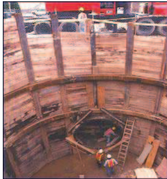
Fig. 3.38 – Suporte vertical convencional em secção rectangular e circular (Bradshaw 2011)
