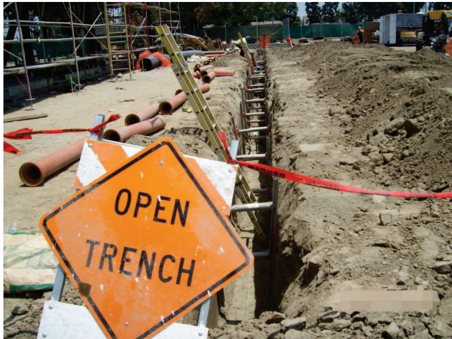
Fig. 2.7 – Construção de um exutor com abertura de vala (Kana Pipeline 2011)
