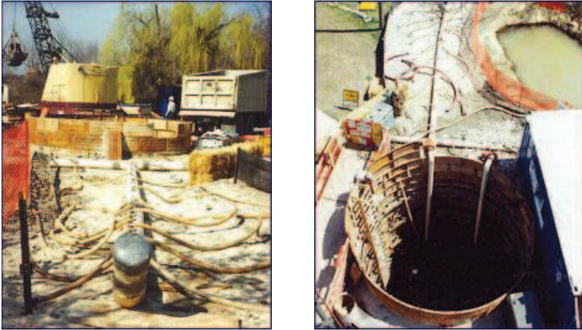
Fig. 3.43 – Rebaixamento do nível freático por bombagem (Bradshaw 2011)
