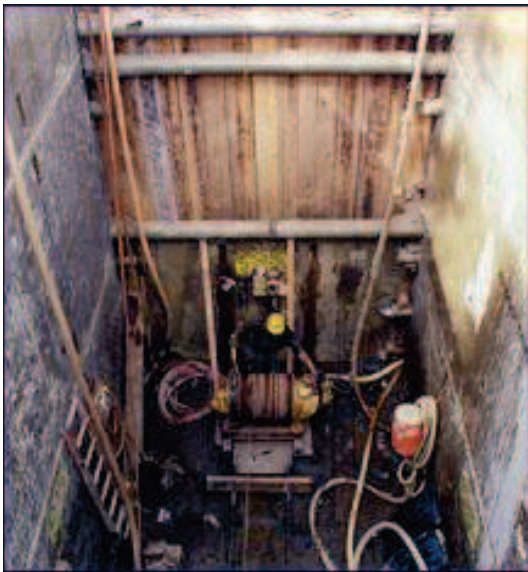
Fig. 3.38 – Suporte vertical convencional em secção rectangular e circular (Bradshaw 2011)
