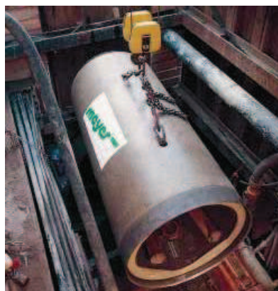
Fig. 3.8 – Tubo composto de agregados e resina de poliéster POLICRETE® (Meyer 2011)
