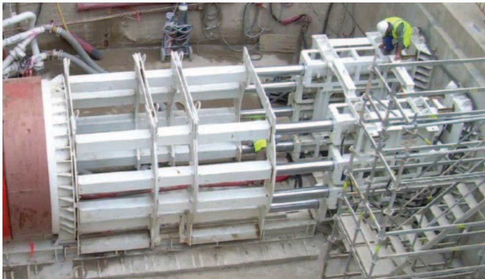
Fig. 3.30 – Equipamento de empurre com macacos de curso curto e espaçadores metálicos (Iseki 2009)
