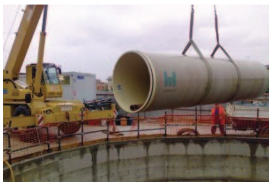
Fig. 3.5 – Tubo de fibra de vidro (GRP) (HOBAS 2011)
