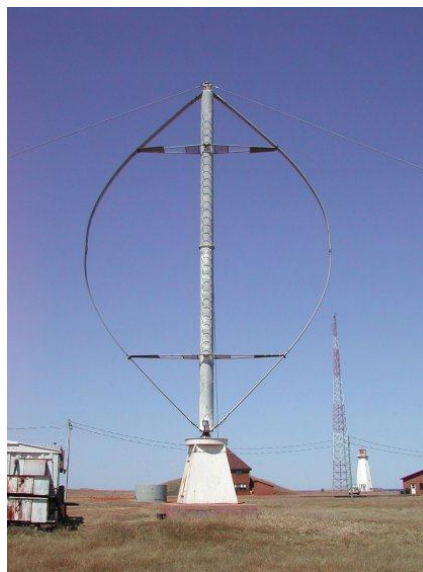
Fig.2.6 – Turbina de Eixo Vertical [9]
