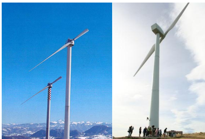
Fig.2.8 – Modelos de uma [11] e de duas pás [12]
