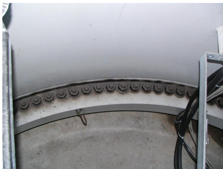
Fig.4.6 – Flange do fundo aparafusada
