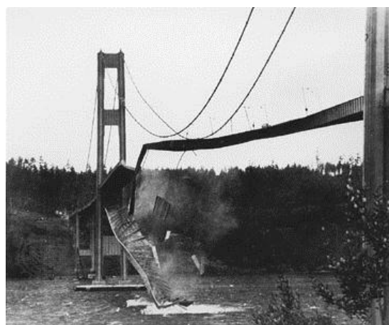
Fig.3.3 – Ruína da ponte [23]
