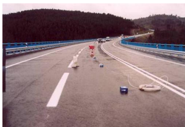
Fig.5.4 – Sismógrafos dispostos ao longo do tabuleiro da ponte [20]
