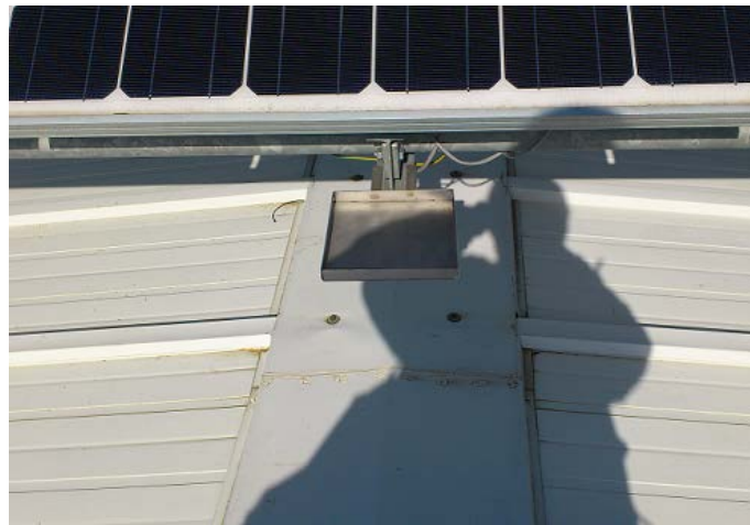
Figura 5.13: Suporte e posição dos sensores
