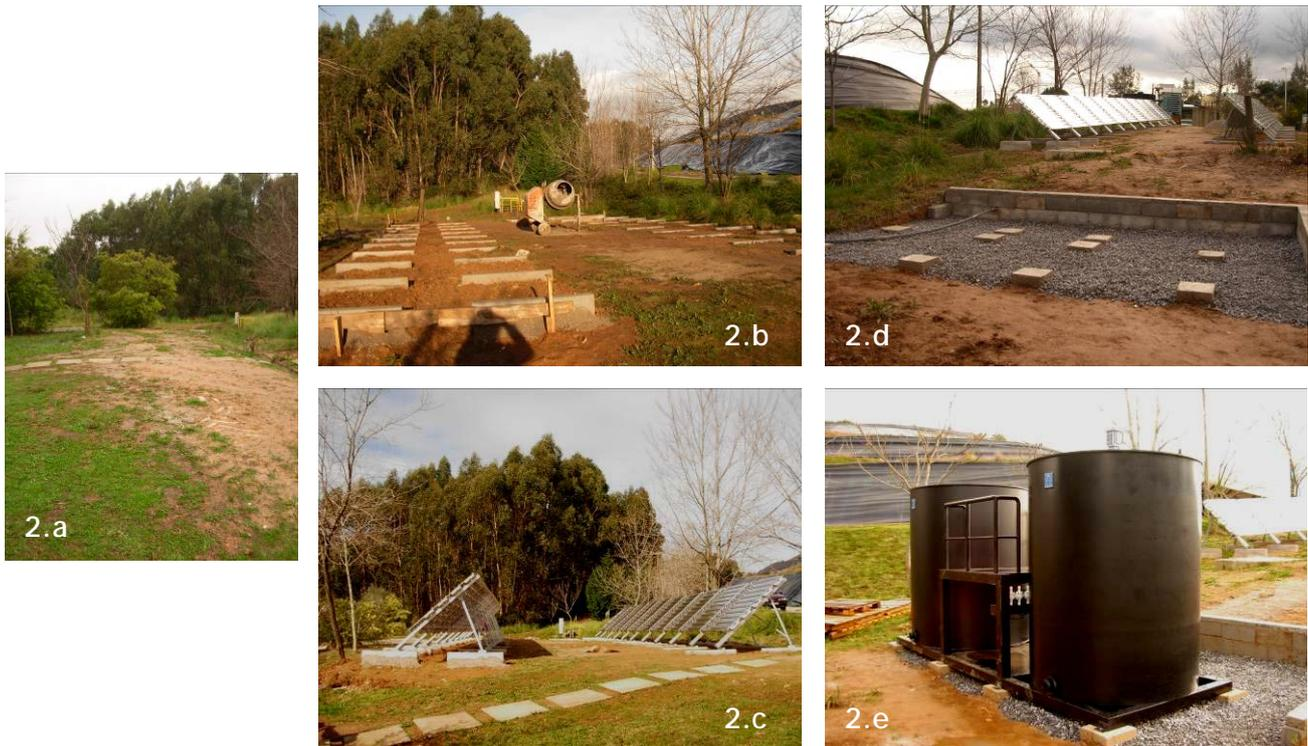
Figura 3.1.1- Fases da construção da Unidade Experimental: 2.a - Local antes dos trabalhos; 2.b - Construção dos maciços; 2.c - Colectores solares; 2.d - Plataforma de apoio dos tanques; 2.e - Tanques
