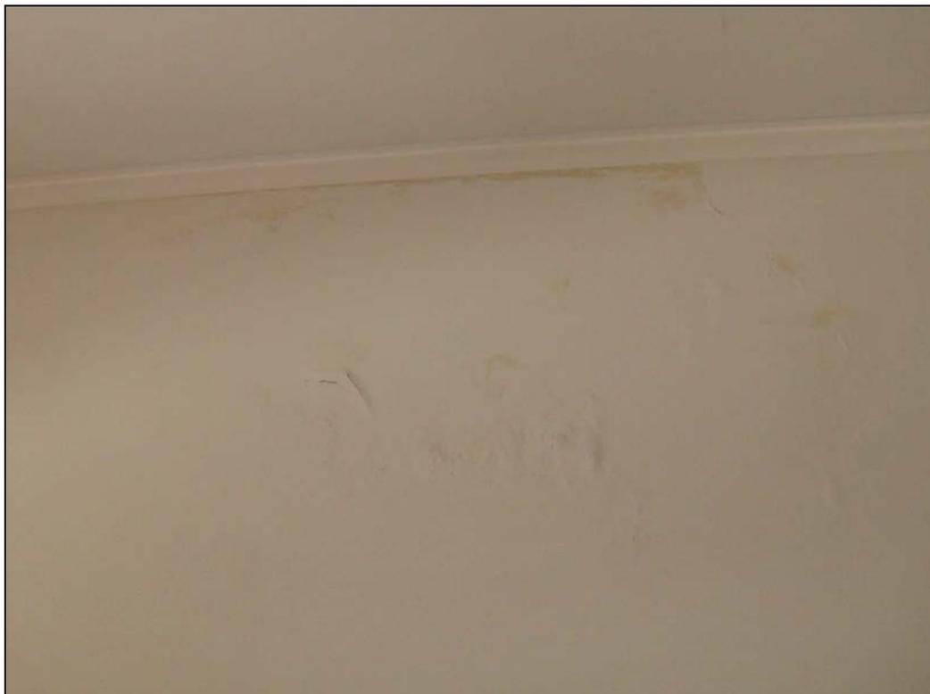
Fig.8 – Exemplo de anomalia\_02: rutura de canalizações - parede de habitação
