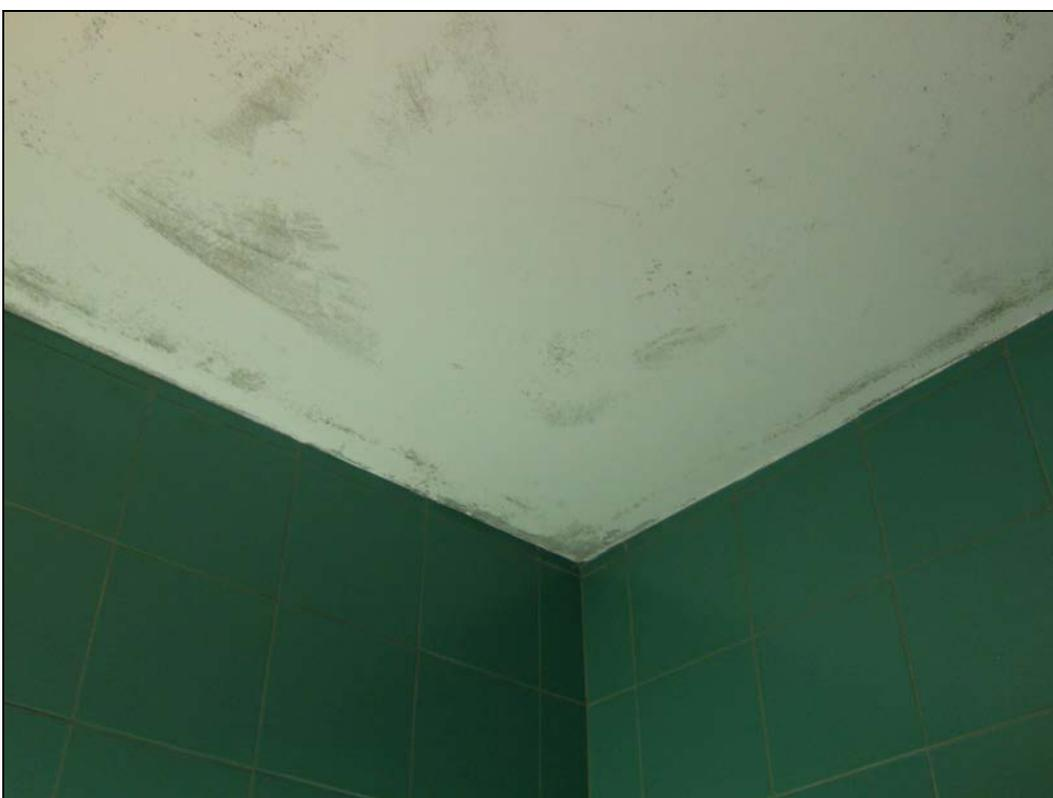
Fig.11 – Exemplo de anomalia\_05: condensações – teto de instalação sanitária
