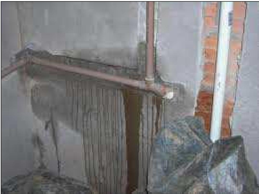
Fig.7 – Exemplo de anomalia\_01: rutura de canalizações - parede de habitação
