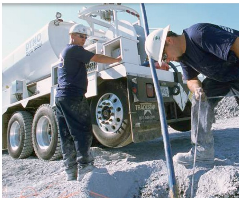
Fig. 26 – Camião de carregamento de emulsão – DYNO Nobel
