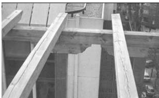
Figura 89 – Empenamento de vigas de madeira (Rodrigues, R., 2004)
