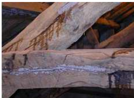
Figura 142 – Preenchimento de fissuras com resina de epóxico
