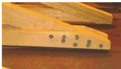
Figura 53 – Ligação perna-linha (ROTAFIX, 2007)
