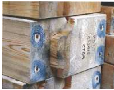
Figura 129 – Peças com furos para introdução de varões embebidos em resinas
