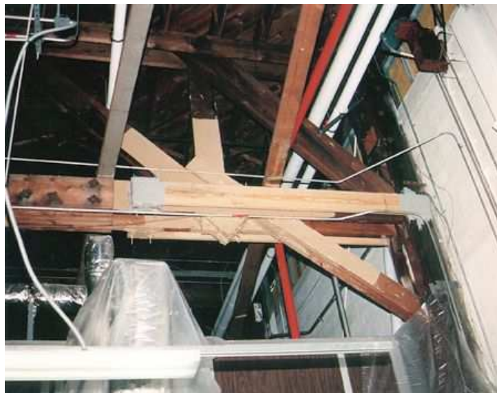
Figura 143 – Consolidação de peças fissuradas com resinas de epóxico ( TimberRepair ® , 2007)
