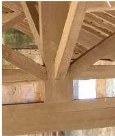
Figura 58 – Exemplo de uma ligação mal concebida entre o pendural e a linha (Branco, J., 2006)
