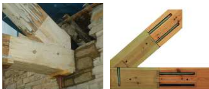
Figura 135 – Prótese de nova madeira na ligação perna-linha ( ROTAFIX , 2007)
