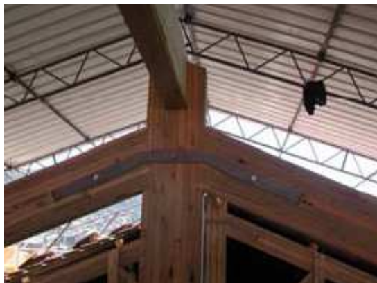
Figura 55 – Ligação pendural – pernas em asna nova (Rodrigues, R., 2004)
