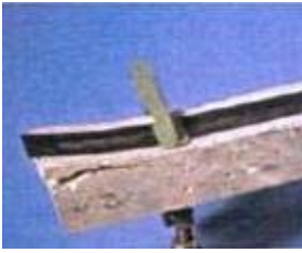
Figura 2. 31 – Delaminação: a fibra pré-esforçada é separada da viga de betão [25]
