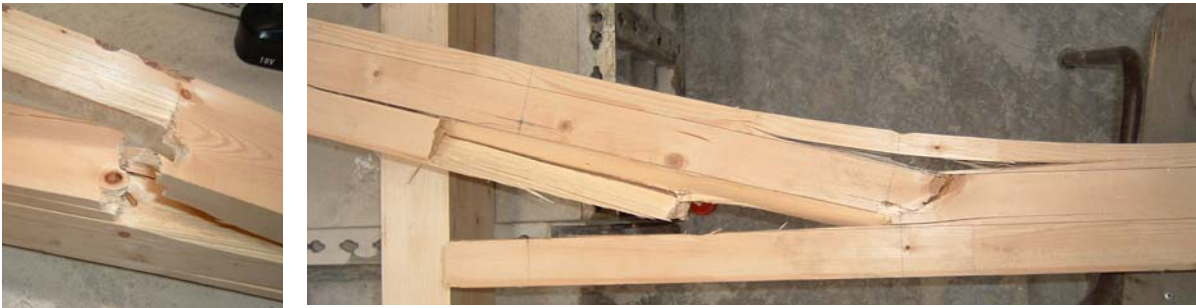
Figura 4. 47 – Rotura da viga V10.
