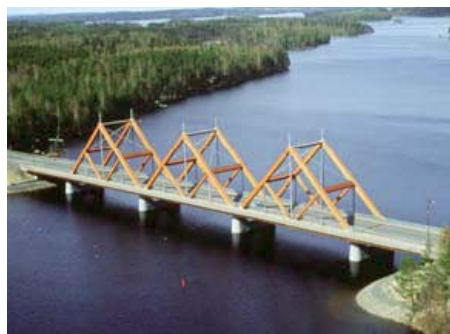
Figura 2. 3 - Ponte rodoviária em Vihantasalmi, Finlândia, 1999 [7]
