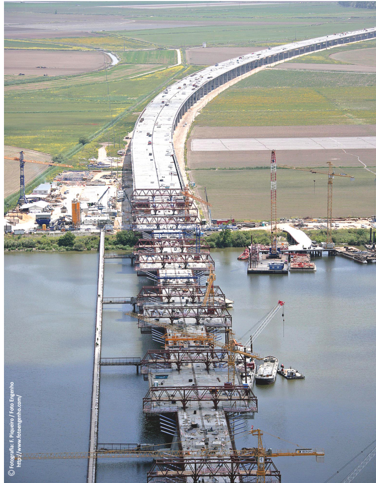
Figure 1.7 : Lezíria Bridge at May 2007 (© F. Piqueiro / Foto Engenho).
