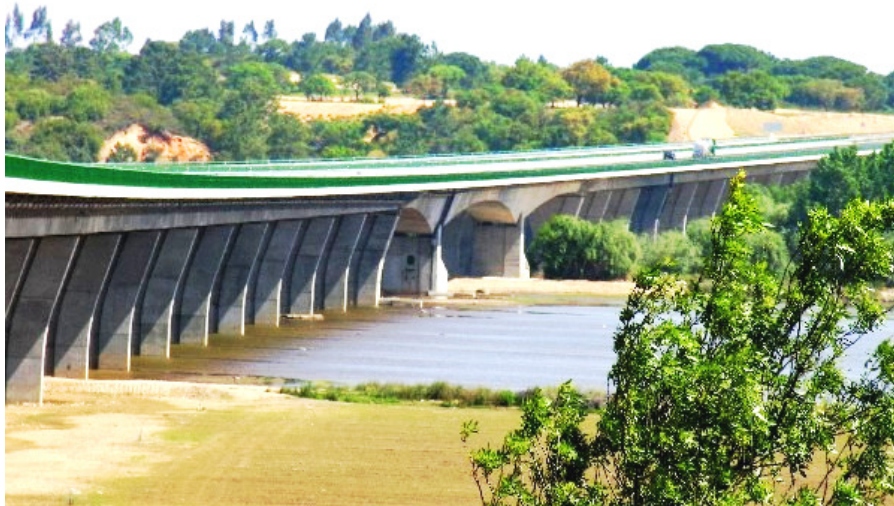
Figure 5.8 : Sorraia Bridge (© Brisa Engenharia e Gestão (BEG)).
