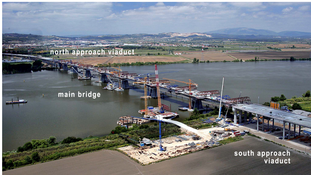
a) Aerial view of Lezíria Bridge – May 2007 (© F. Piqueiro / Foto Engenho).
