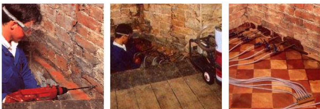
Fig.3.13 – Introdução de produtos hidrófugos ou tapa-poros: aplicação por injeção [15]
