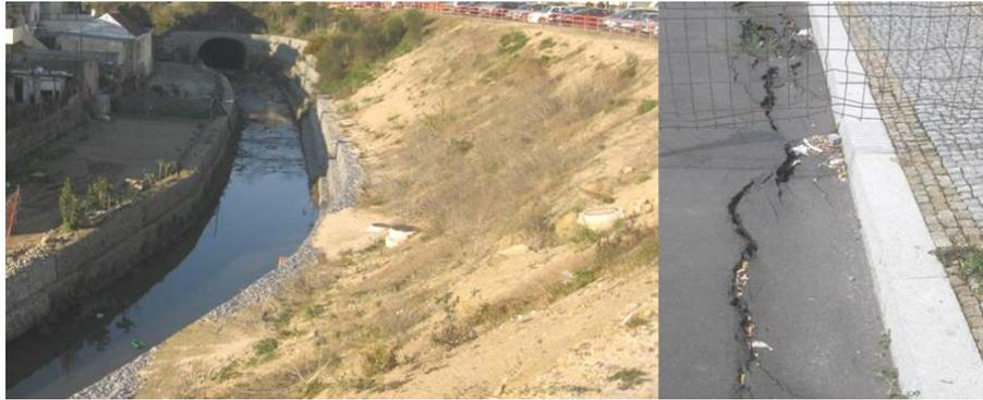
Figura 4.14 – Erosão do talude.
