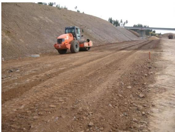
Figura 51 - Passagem de cilindro de rolos
