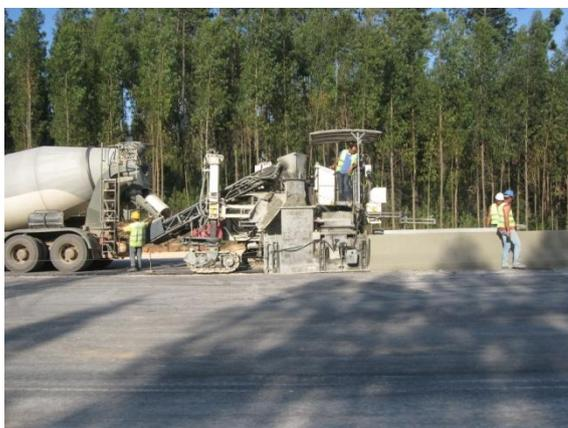
Figura 81 - Execução do separador central
