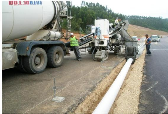
Figura 83 - Execução de caleira de rasgo contínuo
