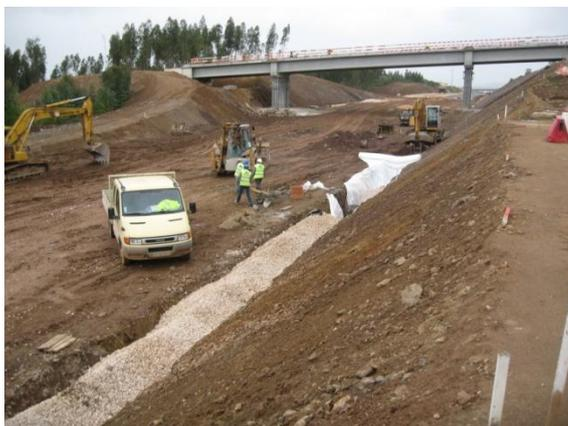
Figura 42 - Execução de dreno longitudinal
