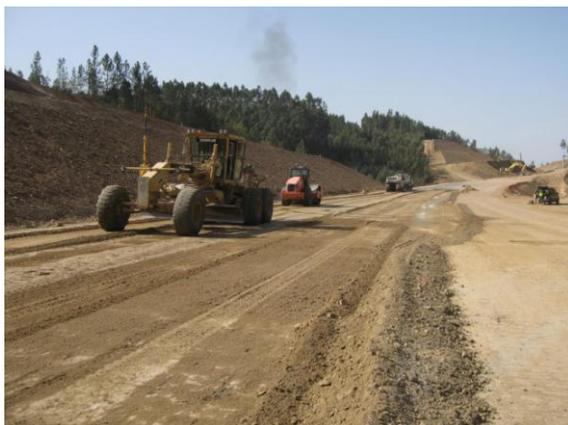
Figura 65 – Equipamentos para execução da camada de solo-cimento
