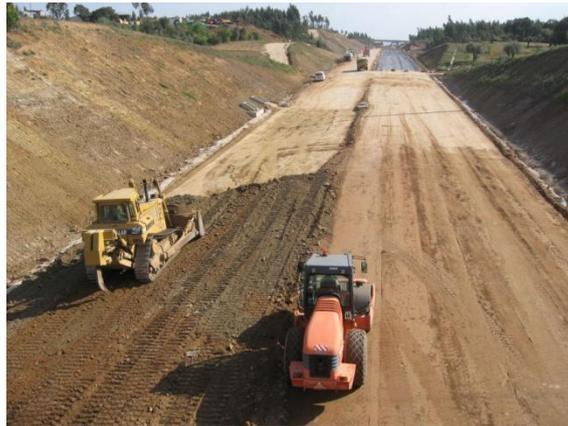
Figura 70 - Aplicação da camada de base em ABGE
