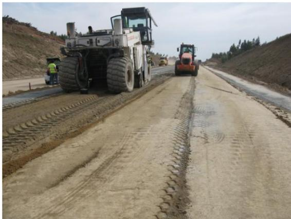
Figura 62 - Passagem de cilindro de rolos compactador
