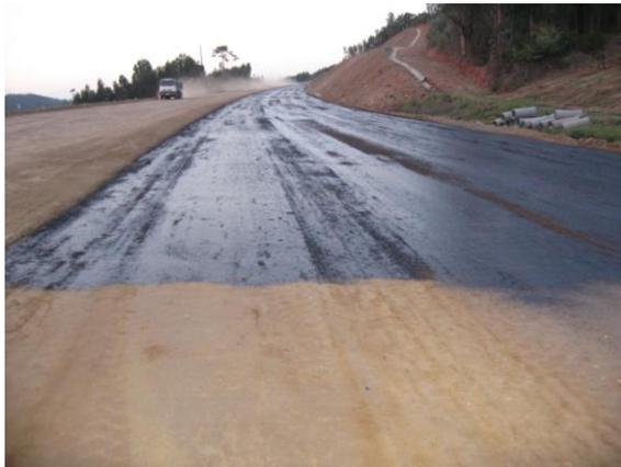
Figura 69 - Aspeto final da camada após tratamento de cura
