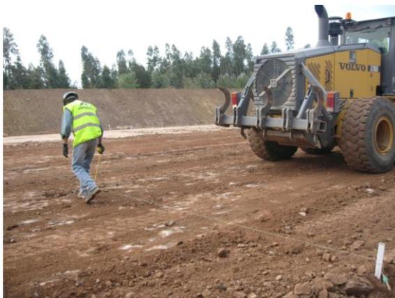
Figura 49 - Verificação da cota da camada
