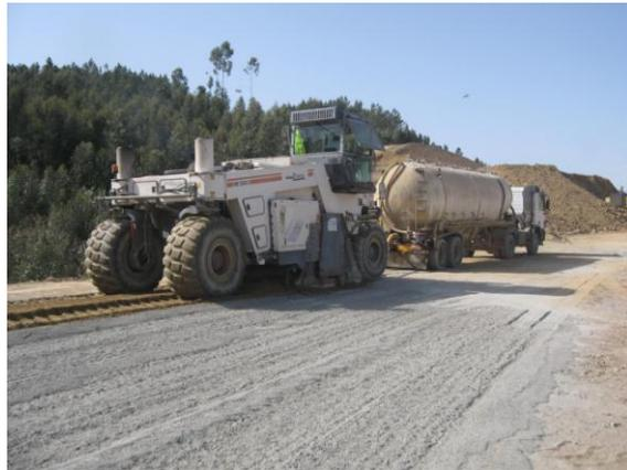
Figura 57 - Mistura do cimento com solo
