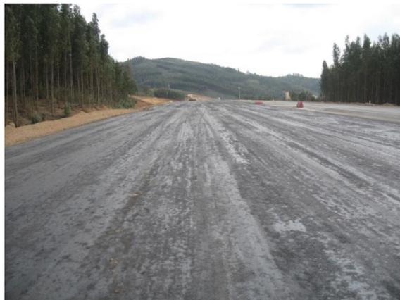
Figura 74 - Aspeto da camada de base após rega de impregnação
