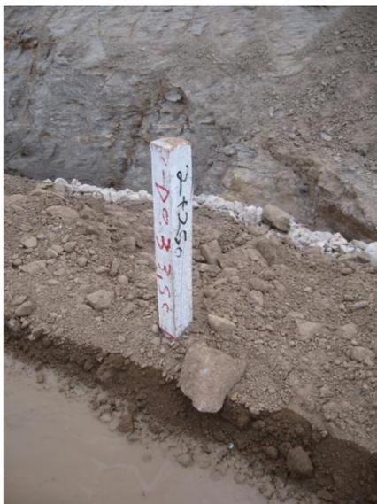
Figura 50 - Estaca com cota de projeto
