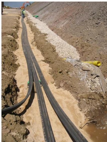
Figura 43 - Canal técnico e dreno longitudinal
