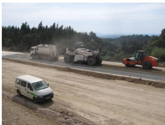
Figura 61 - Compactação ligeira da camada de solo-cimento
