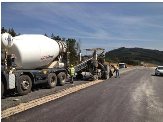
Figura 82 - Execução de separador central
