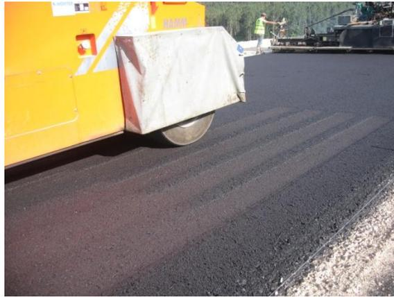
Figura 77 - Pormenor da passagem inicial do cilindro de pneus
