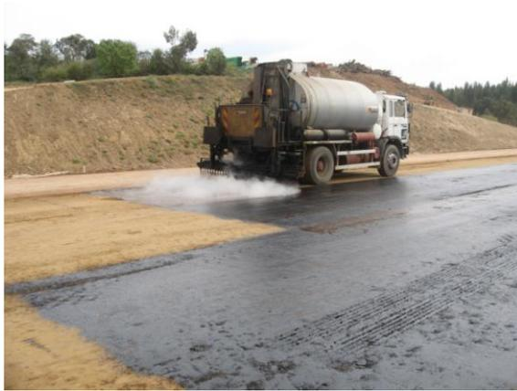
Figura 68 - Tratamento de cura na camada de solo-cimento
