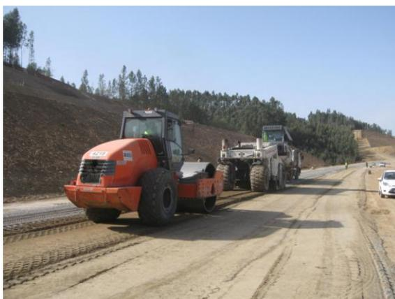
Figura 63 - Passagem de cilindro logo após a fresa
