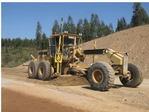
Figura 64 - Nivelamento da camada de solo-cimento
