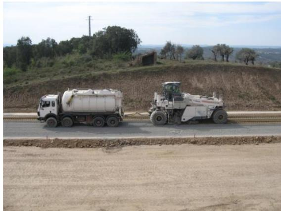
Figura 58 – Equipamento de mistura do cimento
