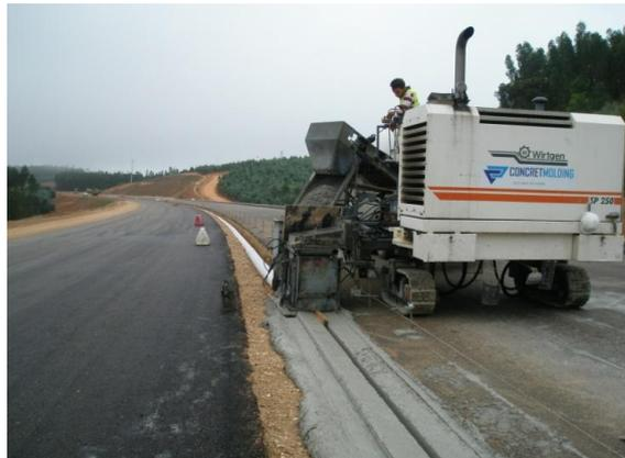
Figura 84 - Pormenor da execução da caleira de rasgo contínuo
