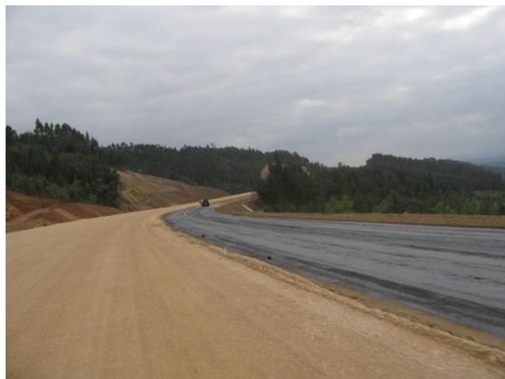
Figura 71 - Camada de base, camada de solo-cimento
