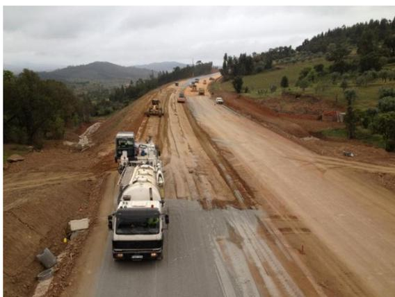
Figura 66 - Fases de execução da camada de solo-cimento
