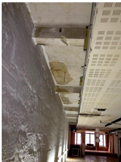
Figura 44 – Estrutura do piso 1 vista do piso 0
