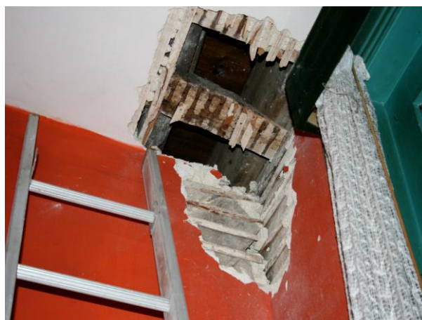
Figura 62 – Parede e teto em tabique [38]
