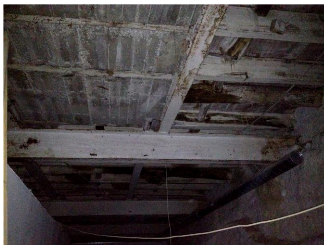
Figura 69 – Pavimento piso 0 visto do piso -1
