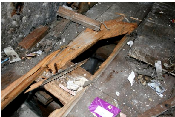
Figura 87 – Degradação superficial do pavimento [38]
