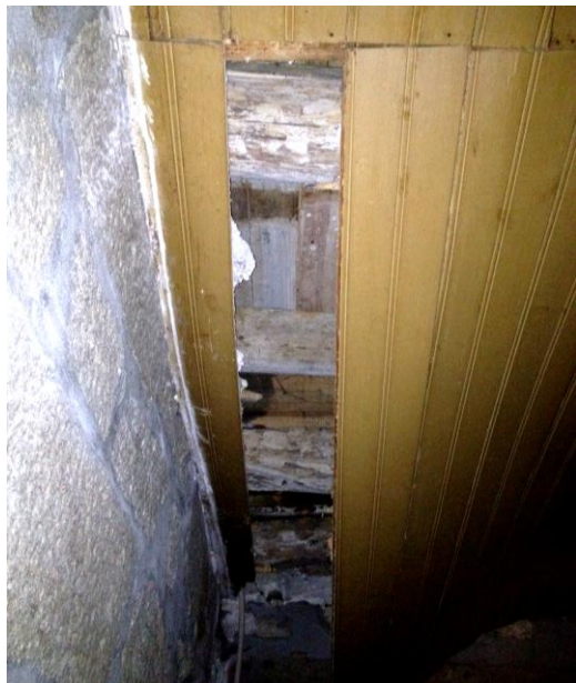
Figura 47 – Pormenor soalho sobre vigas
