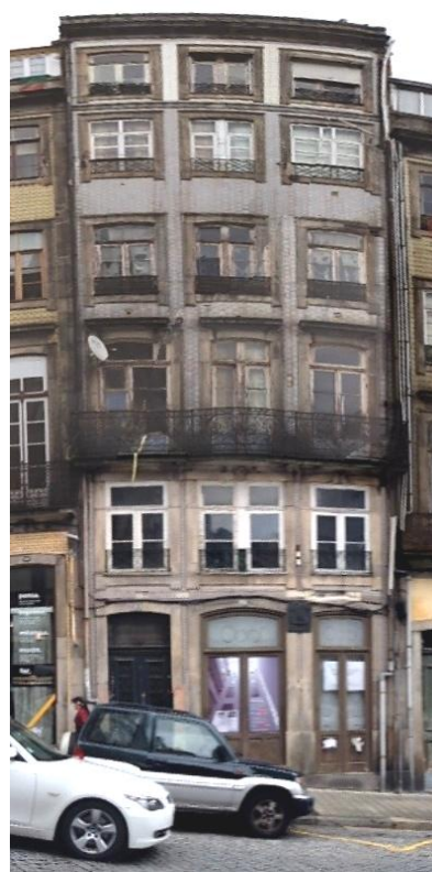
Figura 32 – Fachada atual rua Ferreira Borges
