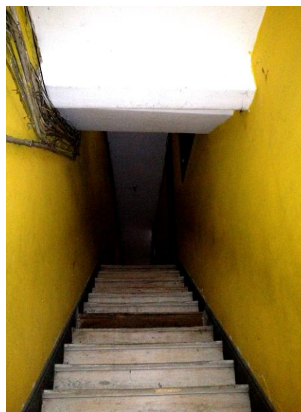
Figura 46 – Revestimento em madeira dos degraus
