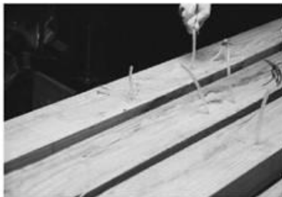
Figura 123 – Colagem de fendas em vigas de madeira [53]
