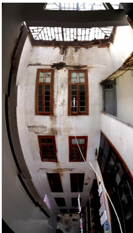
Figura 92 – Parede de tabique no saguão contínua do 1º ao 6º piso
