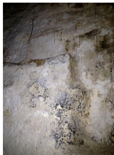
Figura 59 - Parede da empena sul ao nível do piso 1
