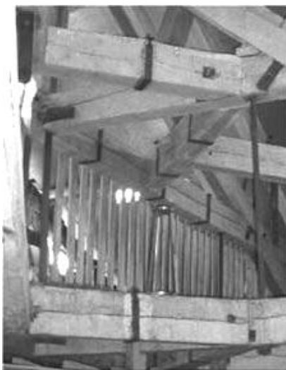
Figura 122- Cintagem de vigas de madeira [53]
