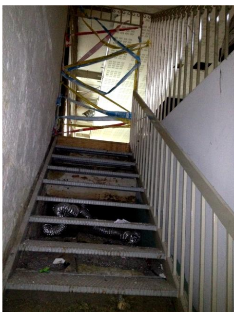
Figura 70- Escadas ligação piso -1 ao piso 0 do lado da rua Ferreira Borges
