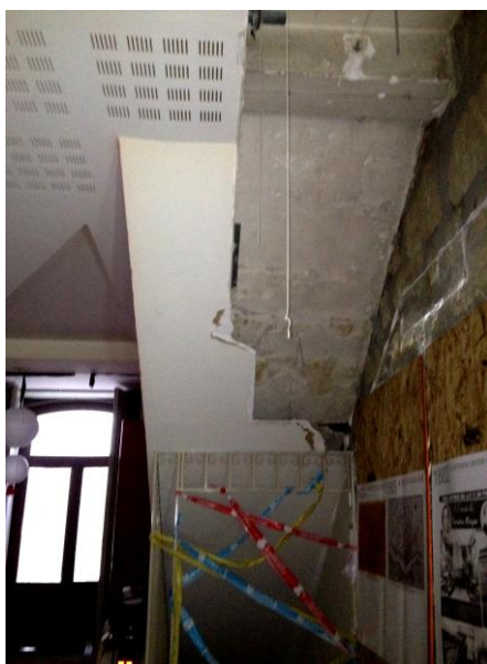
Figura 45 – Estrutura escadas vista de baixo
