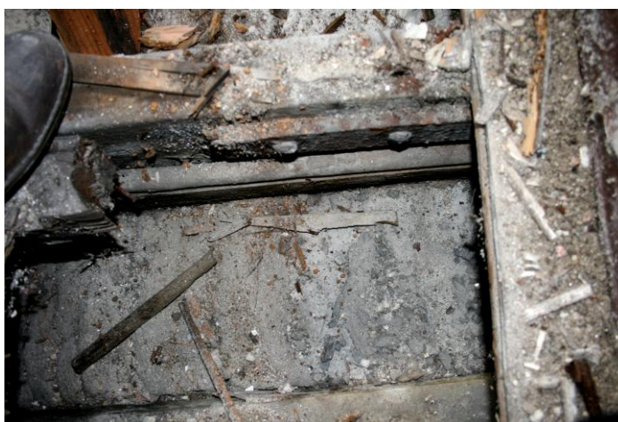
Figura 73 – Ferrolho metálico numa viga de pavimento [38]
