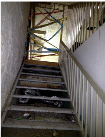
Figura 37 – Caixa escadas metálica
