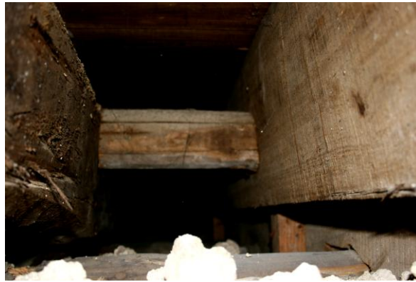
Figura 66 – Elementos que tarugam as vigas de madeira do pavimento [38]
