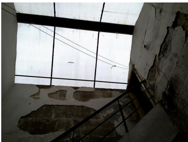
Figura 78 – Claraboia caixa escadas
