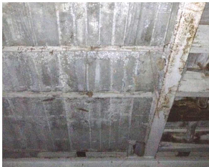
Figura 77 – Pormenor da lajeta de betão betonada in situ
