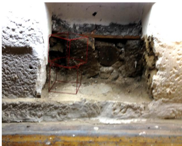
Figura 60 – Abertura parede empena norte ao nível do piso 0
