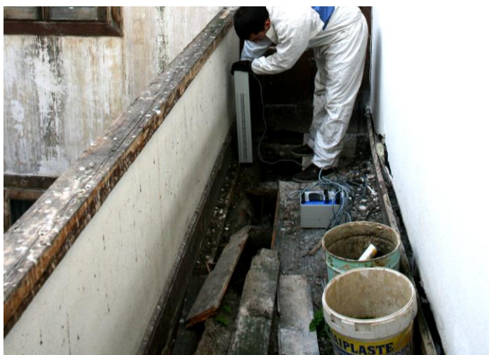
Figura 64 – Guarda de passadiço apoiada em viga de madeira a ser ensaiada [38]
