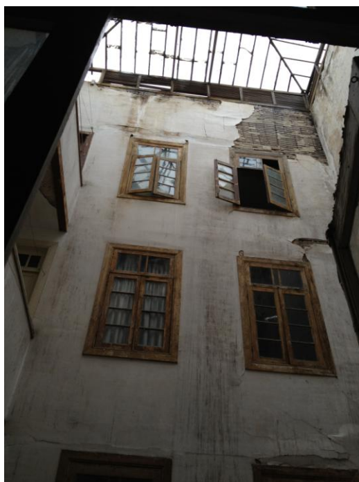
Figura 49 – Paredes exteriores do bloco central em tabique [38]
