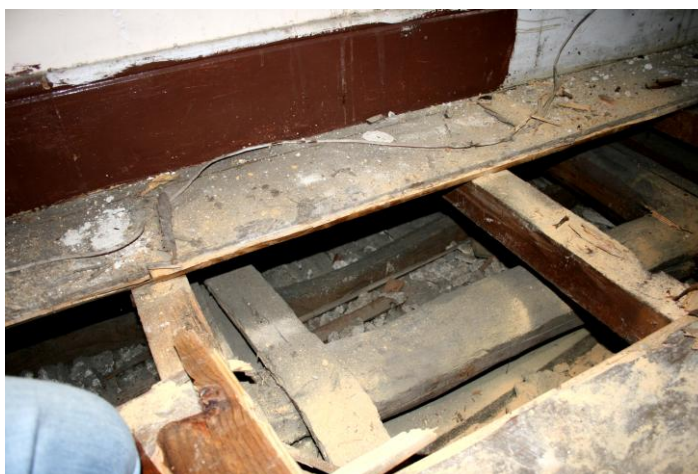
Figura 72 – Camadas de vigas em ripas no pavimento [38]
