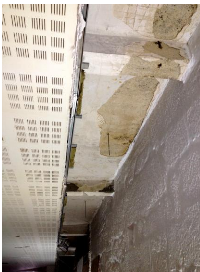
Figura 75 – Estrutura do piso 1 vista do piso 0
