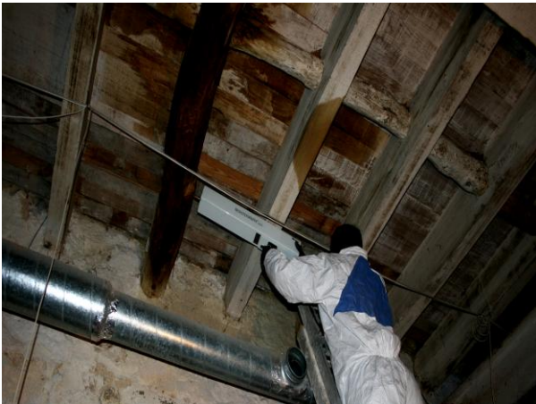
Figura 67 – Reforço com vigas de madeira de secção retângular no piso 0
