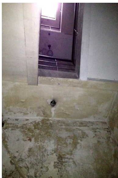
Figura 51 – Vista de baixo das escadas do bloco central
