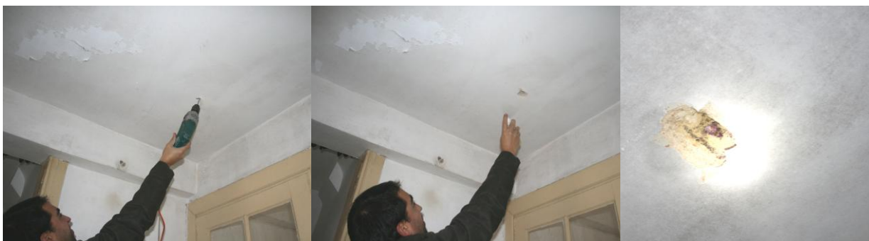
Figura 83 – Picagem superfície betão [38]
