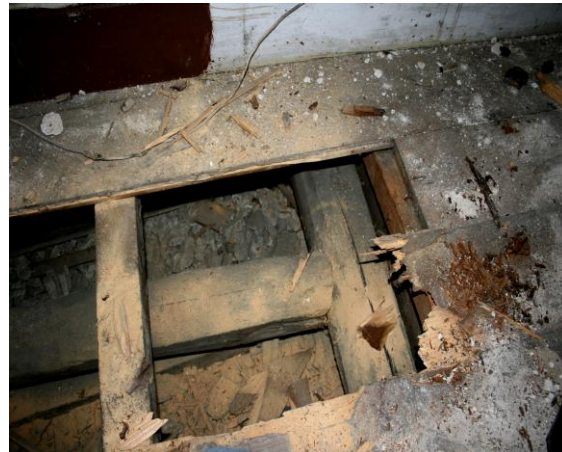
Figura 68 - Reforço com vigas de madeira de secção retângular no piso 5
