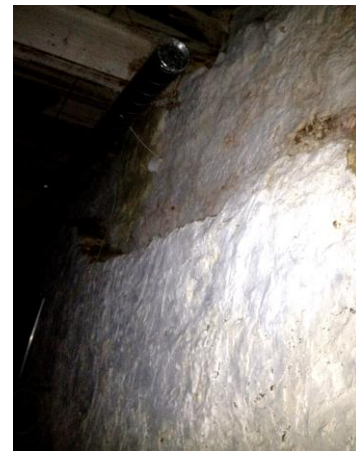
Figura 39 – Socalco parede de empena Sul
