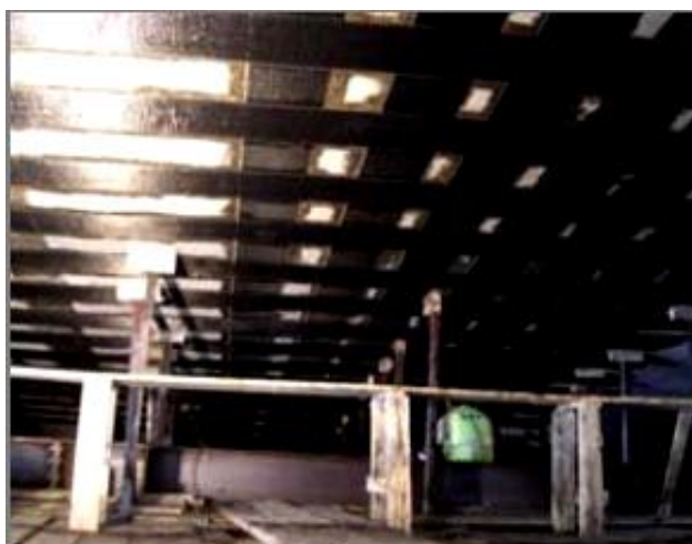
Figura 112 – Reforço de uma laje com FRP laminado [35]
