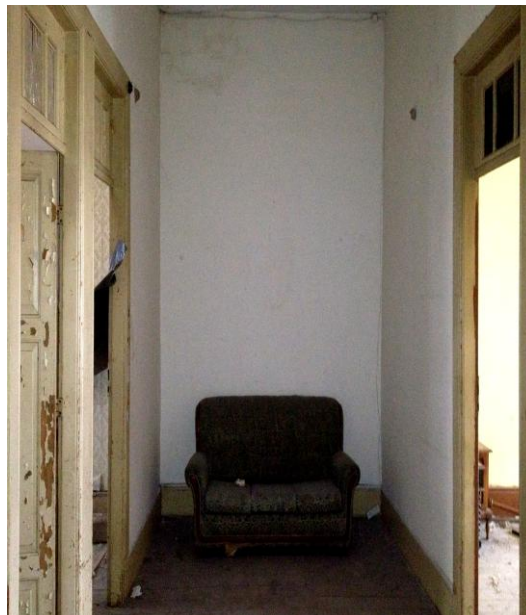
Figura 48 – Paredes divisórias de tabique
