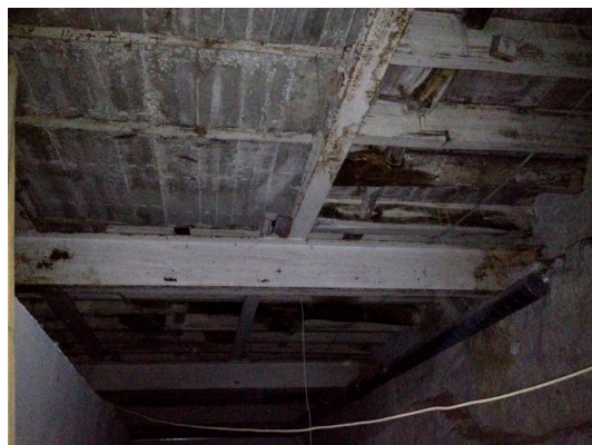
Figura 42 – Lajeta de betão piso 0 vista do piso -1
