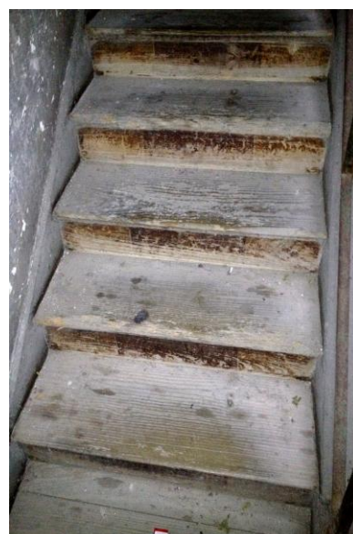
Figura 52 – Revestimento em madeira dos degraus
