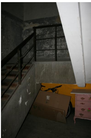
Figura 50 – Escadas do bloco central [38]
