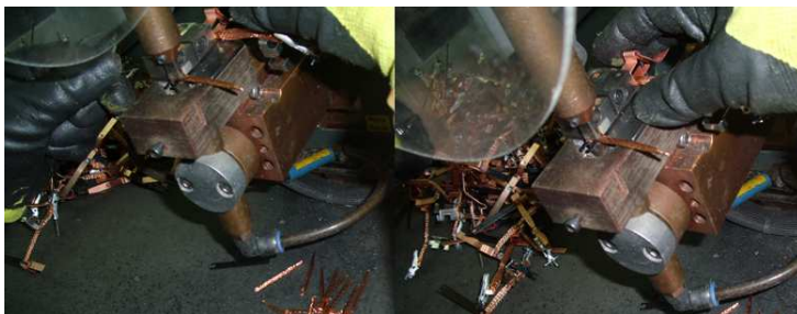
Figura 17 – Operação de soldadura bimetetal-trança
