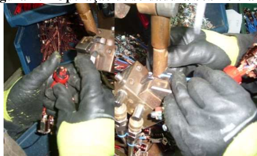
Figura 21 – Operação de soldadura borne curto à trança
