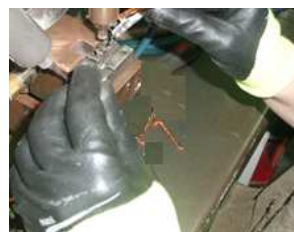
Figura 13 – Operação de soldadura contacto-trança
