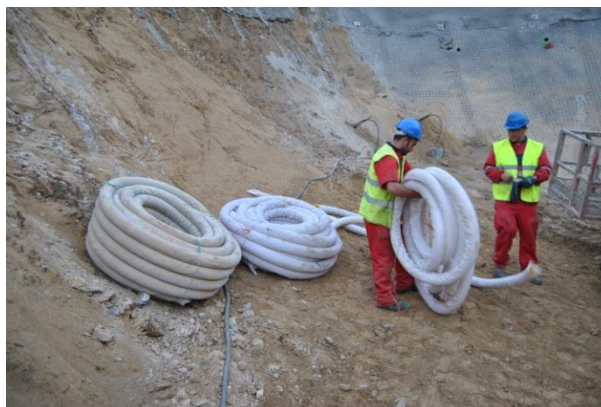
Figura 3.26 – Drenos com manta geotêxtil
