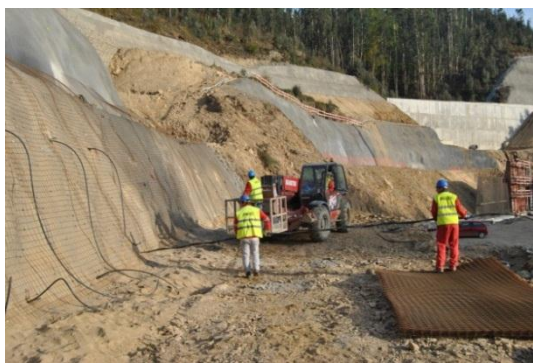
Figura 3.55 – Colocação de Pregagens
