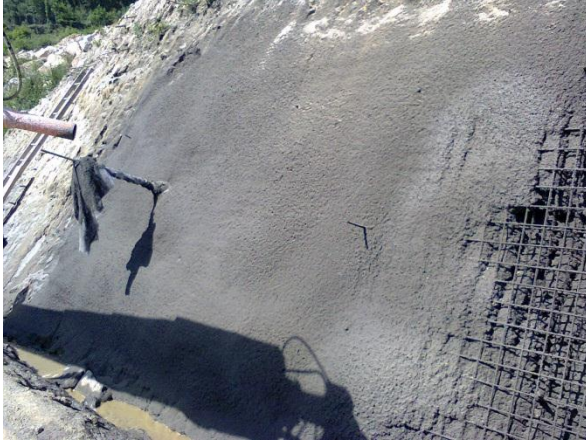
Figura 4.32 - Aplicação do Betão Projetado
