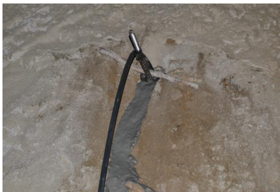
Figura 3.58 - Injeção de Calda
