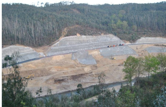
Figura 2.4 – Taludes Pregados no Escalão de Jusante – Ermida
