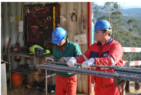
Figura 3.41 - Processo de alisamento dos Varões
