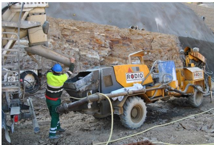
Figura 3.32 –Fornecimento de betão através da autobetoneira ao "Robot"
