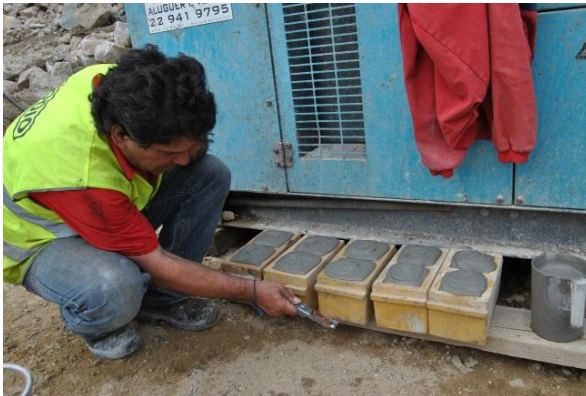
Figura 4.29 - Provetes cúbicos nos moldes - Pregagem 2
