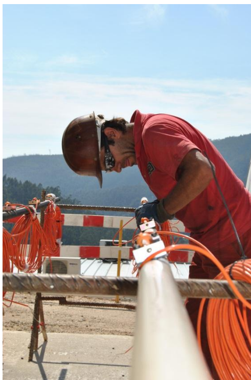
Figura 4.8 - Instalação dos Extensómetros
