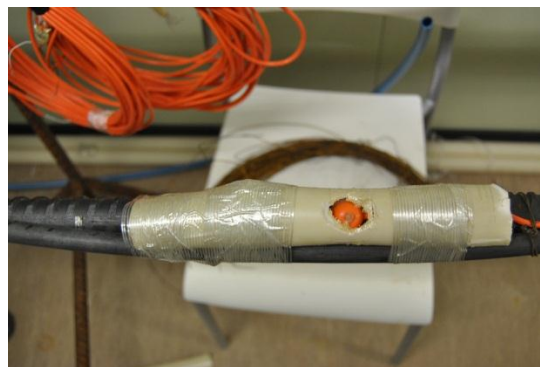
Figura 4.10 - Colocação da Proteção dos Extensómetros
