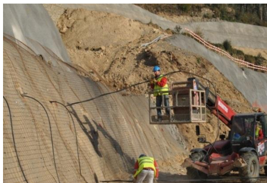
Figura 3.56 - Colocação de Pregagens com o auxílio do Manitou
