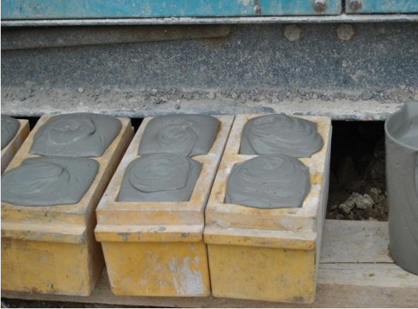
Figura 3.70 - Colocação da Calda nos Moldes
