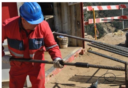
Figura 3.19 - Colocação dos Acopladores
