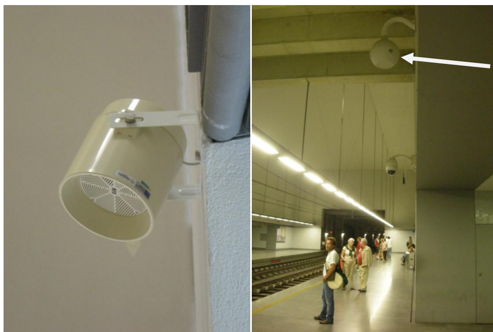
Figura 91 - Fotografias exemplificativas da instalação dos dispositivos
