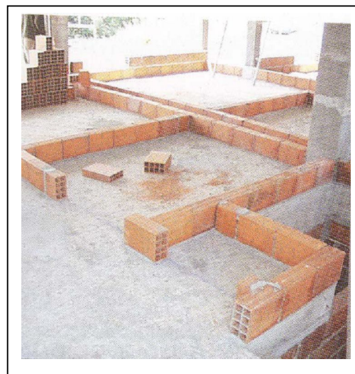
Fig.3.3: Primeira fiada de paredes simples no interior.
