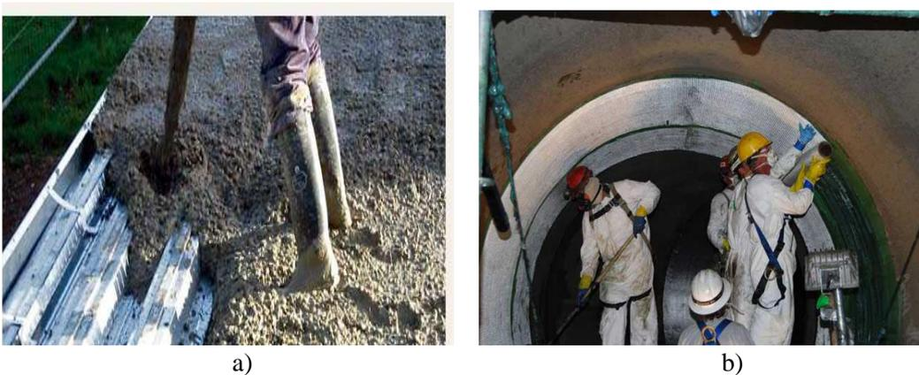
Figura 17 – a) Betão com fibras aplicado num pavimento b) Betão com fibras aplicado num túnel
