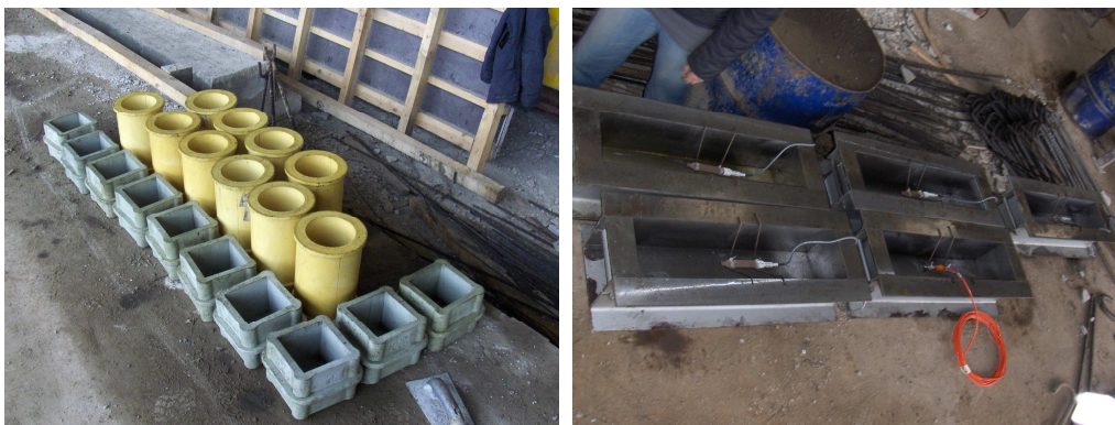
Figura 4.1 Moldes para os provetes dos ensaios de caracterização das propriedades mecânicas do betão
