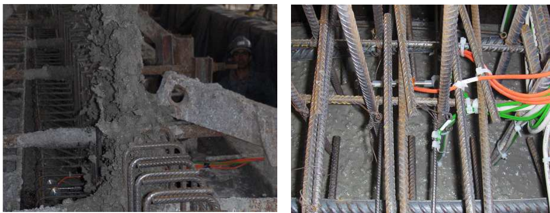
Figura 6.13 Betonagem da viga
