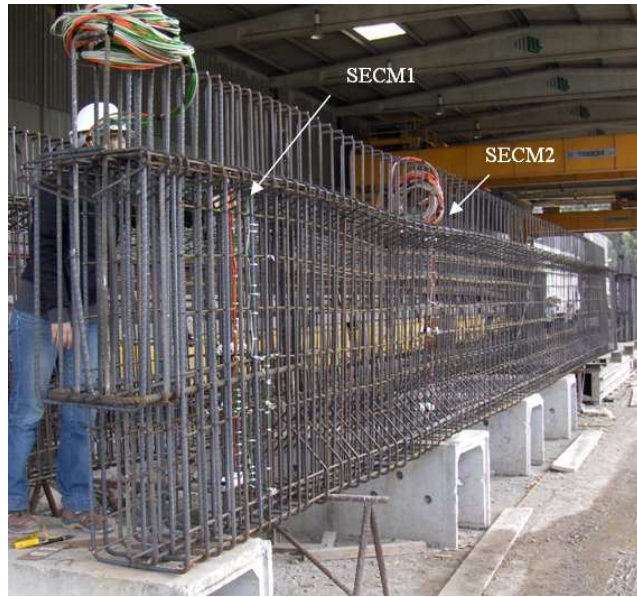
Figura 6.8 Secções de monitorização da viga pré-fabricada
