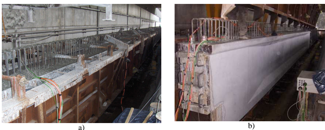
Figura 6.14 a) Viga no final da betonagem; b) após descofragem
