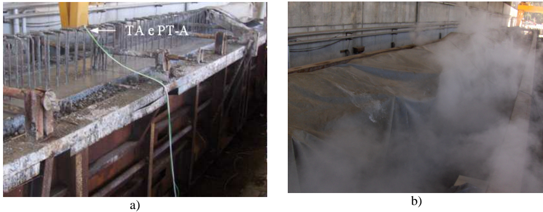
Figura 6.16 a) Termómetros (T-A e PT-A) na viga sujeita a cura térmica de vapor antes da colocação das mantas; b) cura térmica de vapor aplicada a uma viga pré-fabricada do mesmo tipo da instrumentada
