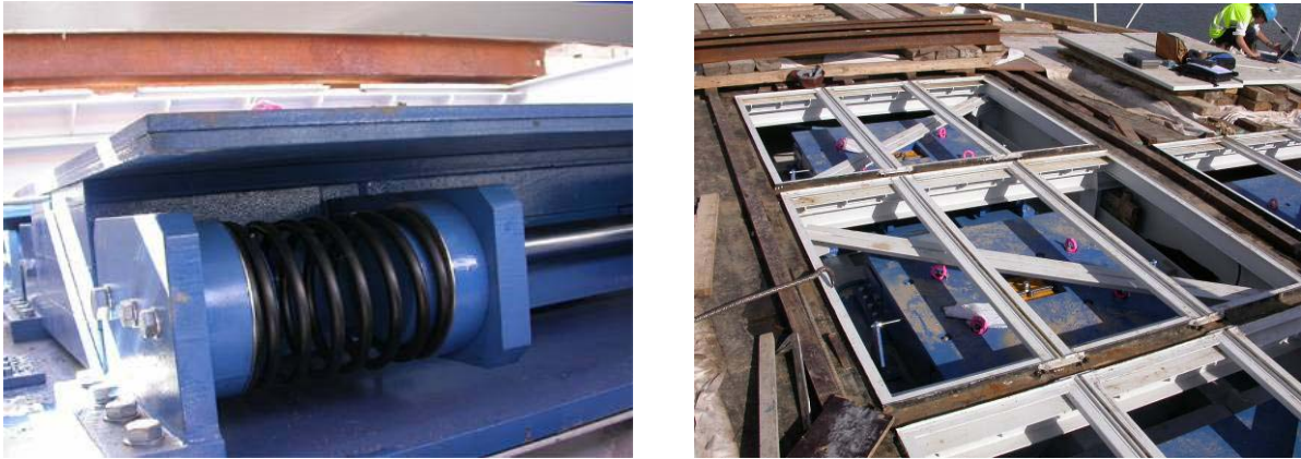
Figura 6.26 – TMD horizontal instalado na secção de meio vão
