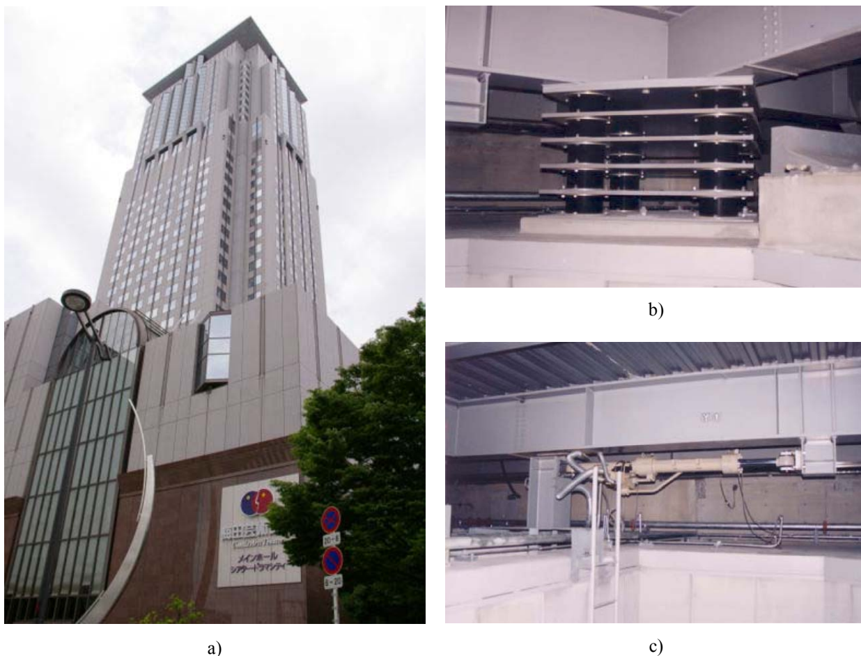
Figura 2.27 – a) Vista geral da “Applause Tower”; b) Aparelhos de apoio da plataforma; c) Actuador hidráulico
