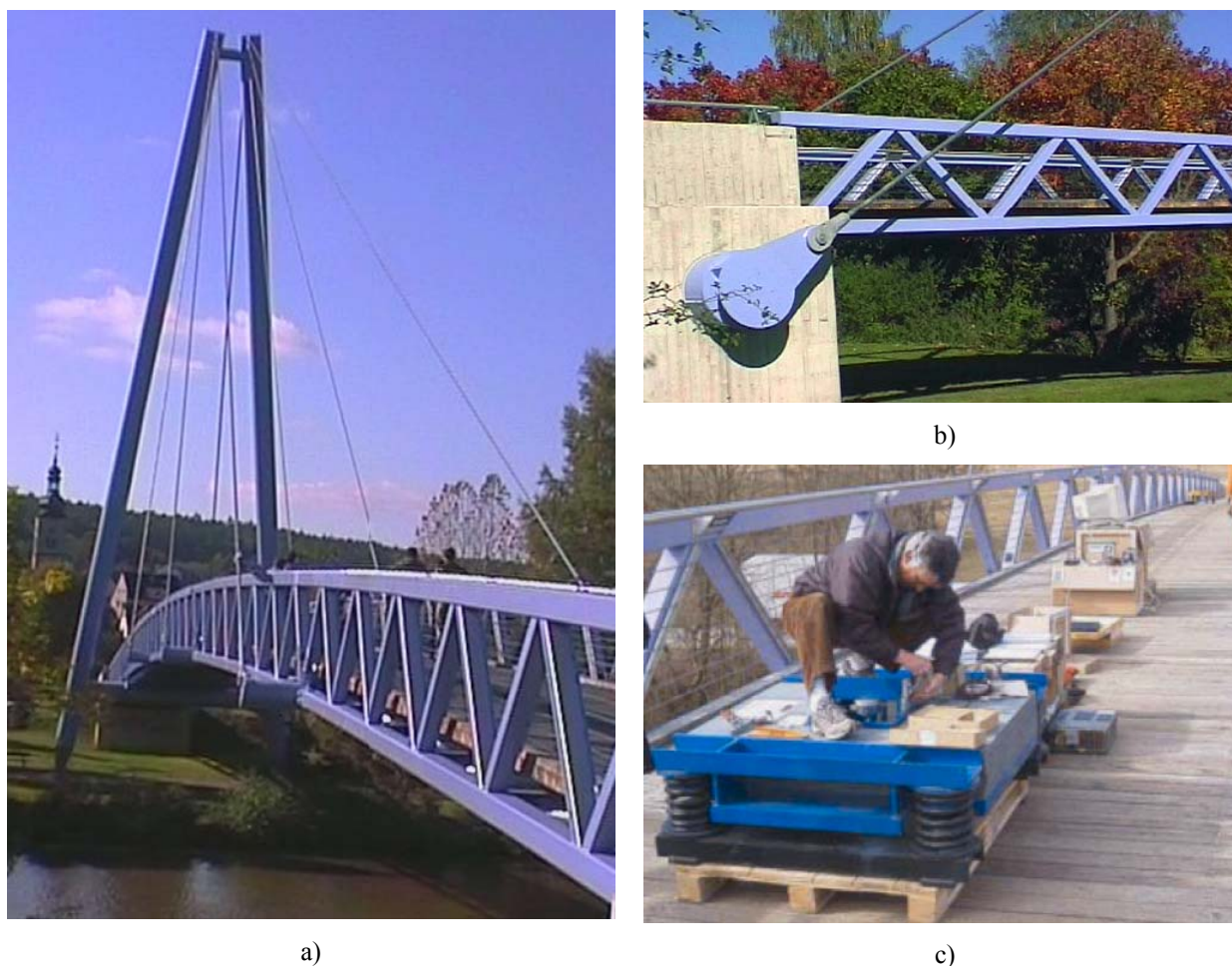
Figura 2.30 – a) Vista da ponte pedonal em Forchheim na Alemanha; b) Detalhe da ancoragem dos tirantes no encontro; c) Instalação de um TMD semi-activo
