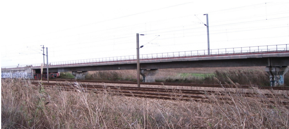
Figura 4.18 - Fotografia de pormenor dos três tramos instrumentados
