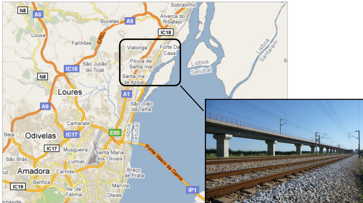
Figura 4.1 - Localização da estrutura em estudo (adaptado de Google (2011))
