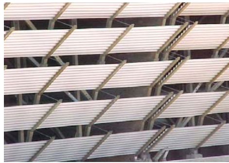
Figura 21 – Grelhas de entrada [www.coolingtowerdepot.com].
