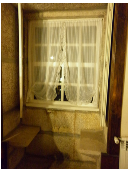
Fig. 5.5 – Estrutura em pedra de granito do vão
