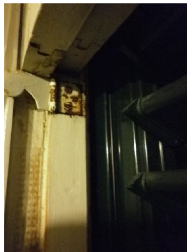
Fig. 5.4 - Ferragens típicas de uma janela de guilhotina
