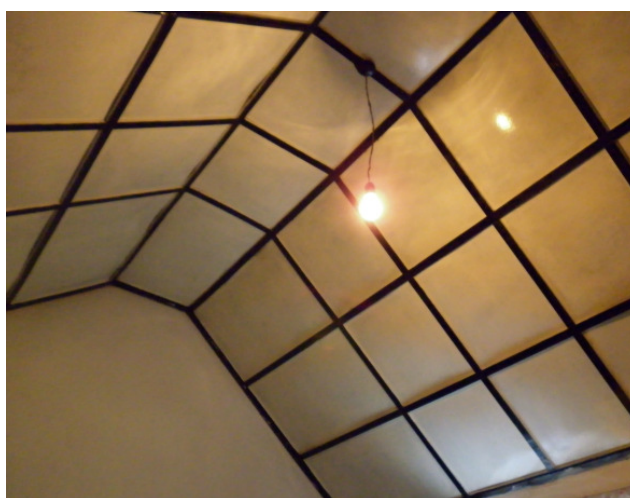
Fig. 4.49 – Teto em madeira pintada de casa de caseiros
