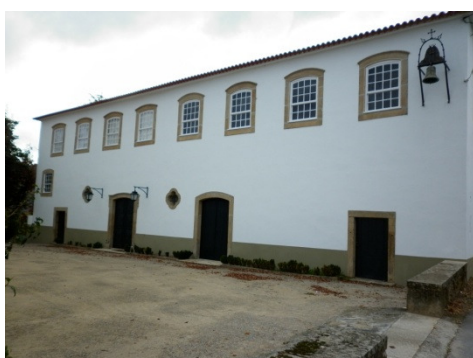
Fig. 4.26 – Fachada rebocada e pintada de branco
