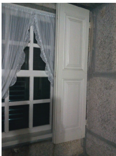
Fig. 4.51 – Portadas interiores em madeira
