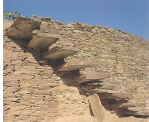
Fig. 4.4 – Muro em xisto com escada formando o efeito de contra-balanço (retirado de [3])
