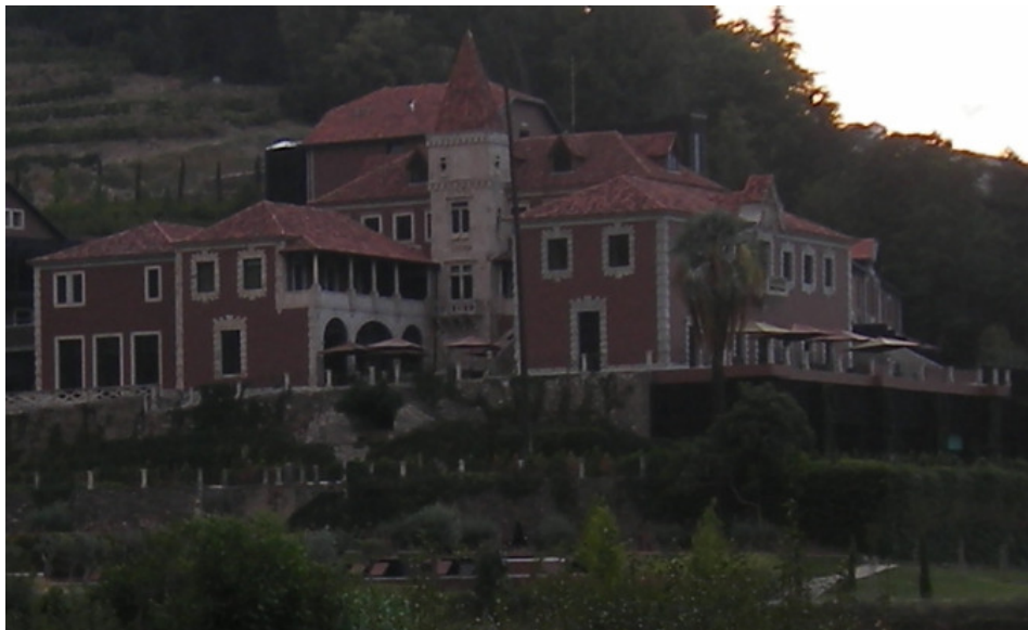
Fig. 3.36 – Edifício principal da Quinta Vale de Abraão após a adaptação a turismo
