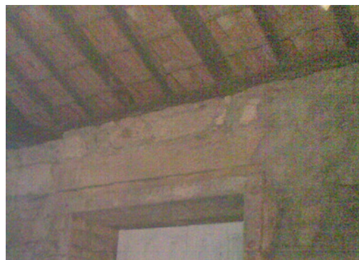
Fig. 4.15 – Cobertura em madeira ainda sem o tecto falso
