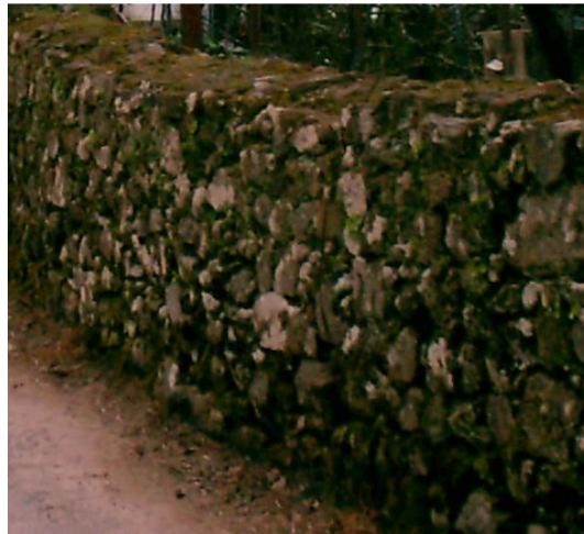
Fig. 4.5 – Muro exterior em pedra
