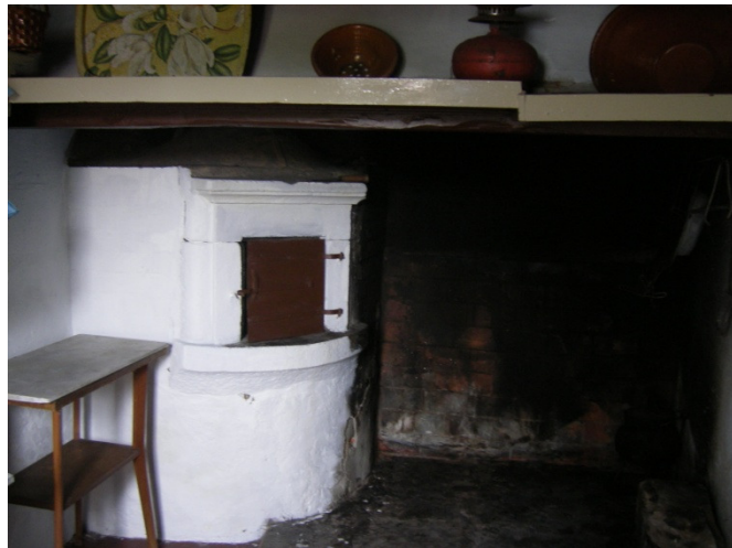
Fig. 4.21 – Lareira de fumeiro em casa de caseiros com forno tradicional
