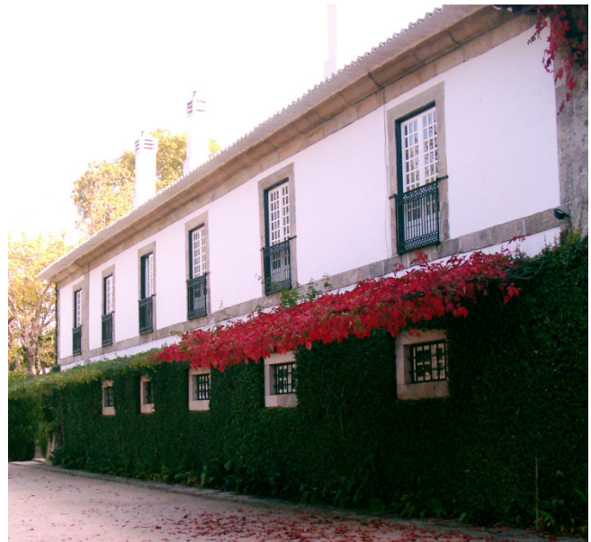
Fig. 4.39 – Janelas de duas folhas em batente
