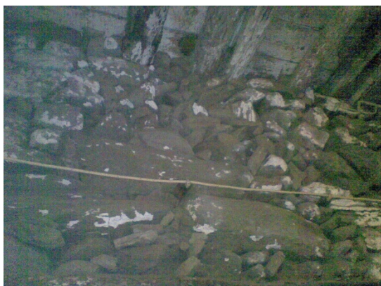
Fig. 4.6 – Parede exterior em pedra vista pelo interior ao nível do piso térreo
