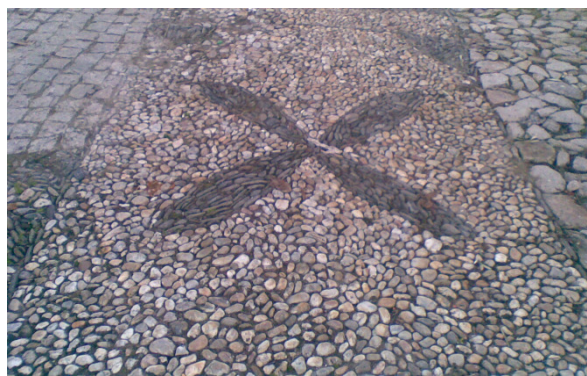
Fig. 4.43 – Pavimento em seixos do rio
