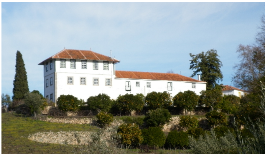
Fig. 3.22 – Edifício principal com acrescento do 3º piso
