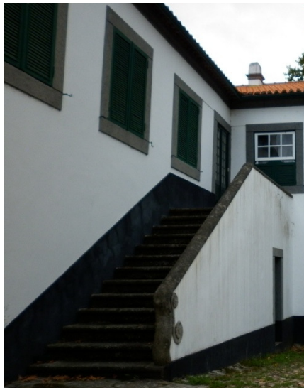
Fig. 4.17 – Escadas em pedra na Quinta do Lodeiro
