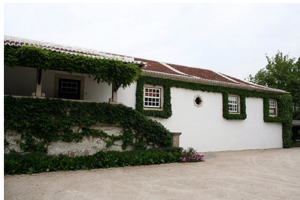
Fig. 3.16 – Casa do Proprietário da Quinta da Pacheca – entrada para varanda alpendrada [52]
