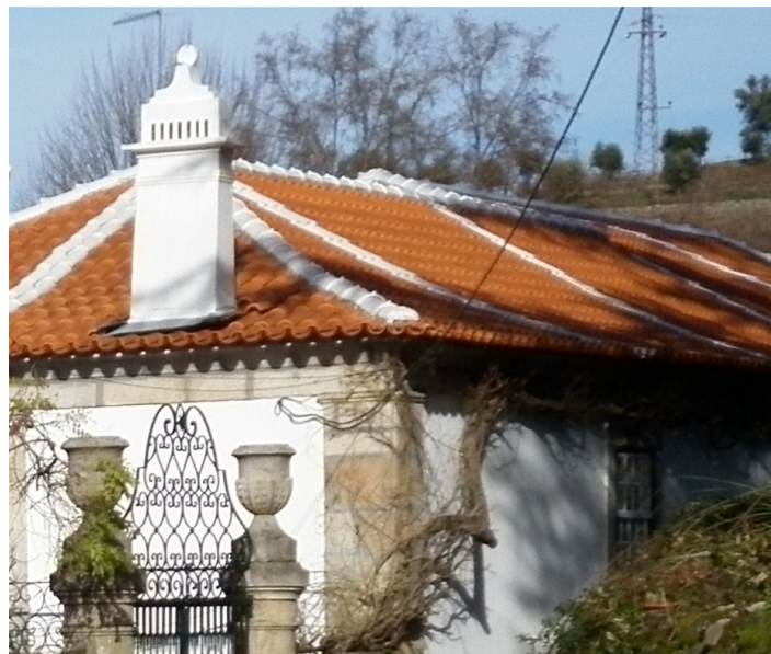
Fig. 4.19 – Telhado da Casa da Azenha
