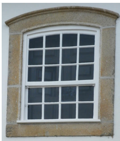
Fig. 4.36 – Janela de guilhotina com cantaria trabalhada e com padieira curva
