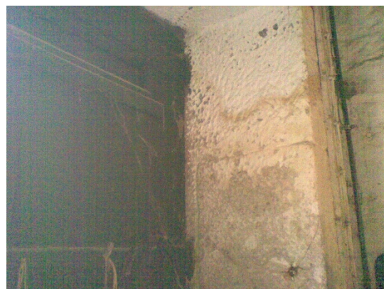
Fig. 4.7 – Parede exterior, envolvente aos vãos em pedras de granito
