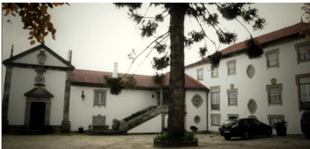
Fig. 3.7 - Quinta de Santa Júlia de Loureiro, fachada norte [50]
