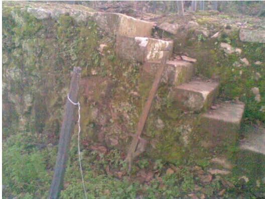
Fig. 4.3 – Muro em granito com escada, retirando espessura ao muro
