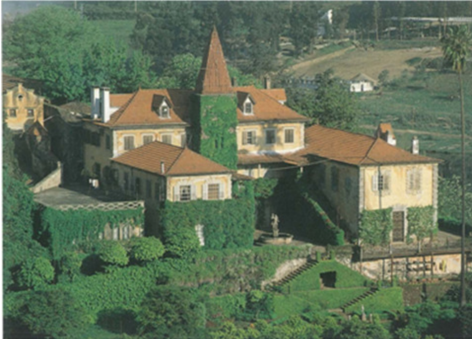
Fig. 3.35 – Edifício principal da Quinta Vale de Abraão antes do incêndio (retirado de [3])
