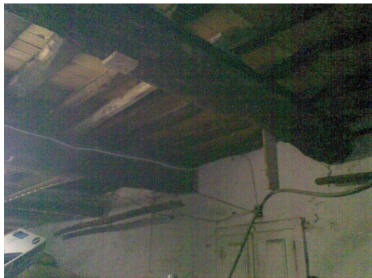
Fig. 4.10 – Estrutura de suporte e pavimento de madeira do piso superior
