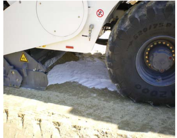
b) Pormenor da mistura do solo com a cal
