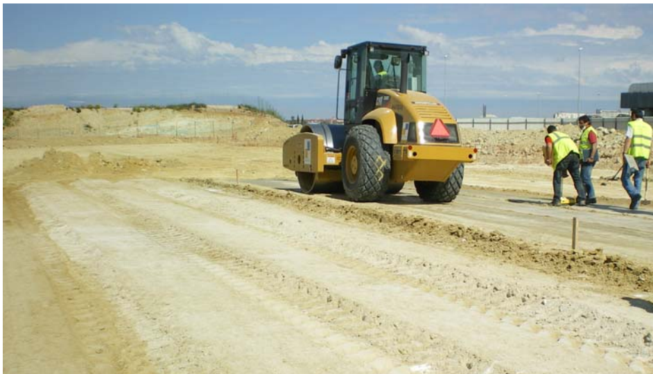
Figura 5.4 – Compactação das camadas estabilizadas com cal no aterro experimental
