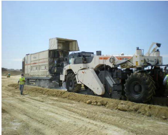
a) Espalhamento da cal seguido da mistura
