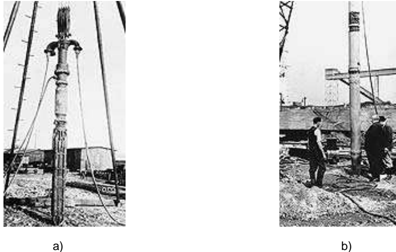
Fig. 2.6 – a) Foto de uma das primeiras sondas vibratórias usadas na técnica de vibrocompactação (1937); b) Foto das primeiras obras de execução de colunas de brita na Alemanha (1950's); [1].
