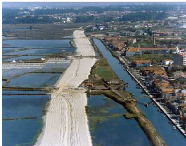
Fig. 3.1 – Troço do antigo IP5, actual A25, durante a aplicação da pré-carga, Aveiro [4].
