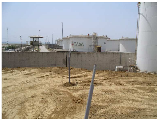
Fig. 3.2 – Reservatórios de combustível construídos após aplicação de pré-carga, Grécia [5].
