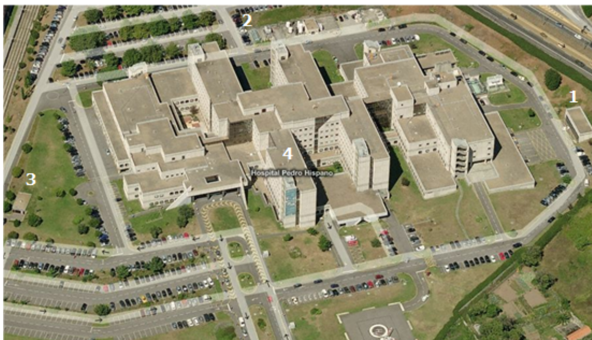
Figura 15 – Vista panorâmica do Hospital Pedro Hispano [42]
