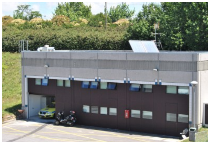
Figura 58 – Edifício do INEM [41]
