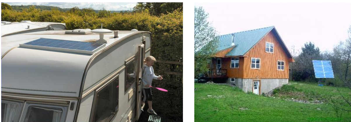
Figura 20. Representação de sistemas fotovoltaicos autónomos montado numa caravana (à esquerda) e num meio rural (à direita), (Eurocosm, 2009).
