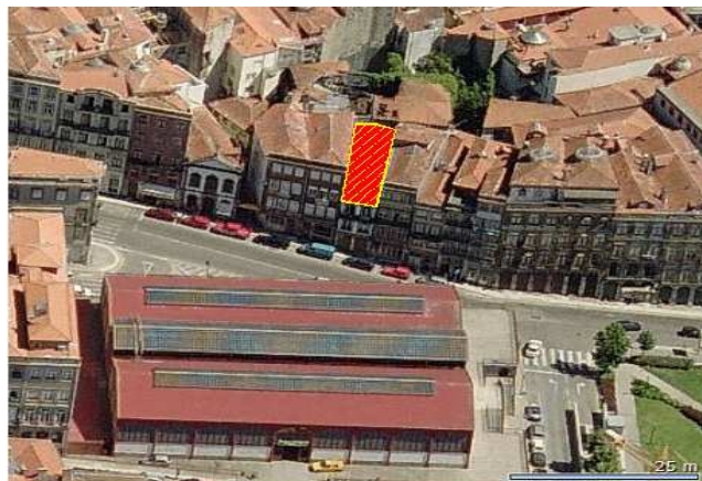
Figura 3.6 – Vista da Rua Mouzinho da Silveira de parte do quarteirão da Feitoria Inglesa, com o edifício em estudo assinalado, ( http://www.bing.com/maps/ ).
