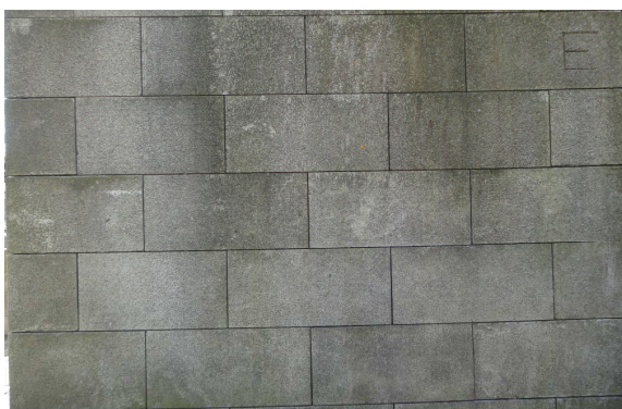
a) Parede 1 (edifício 1) – SE1
