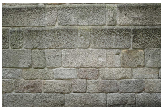
b) Parede 1 (edifício 2) – SE2
