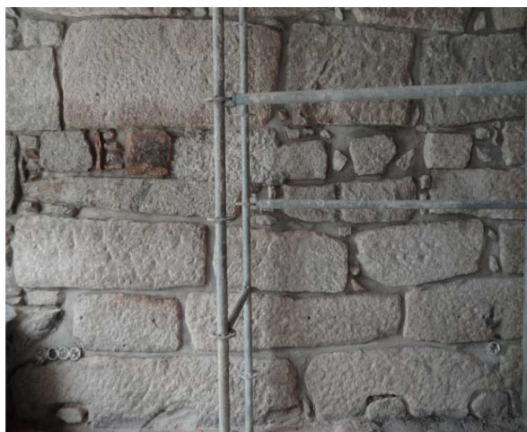
f) Parede 5 (3º piso) – CG6
