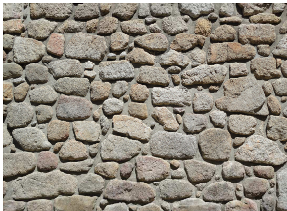
Figura 3.9 – Parede 1 (exterior) do edifício de Vila Nova de Gaia – VG1.
