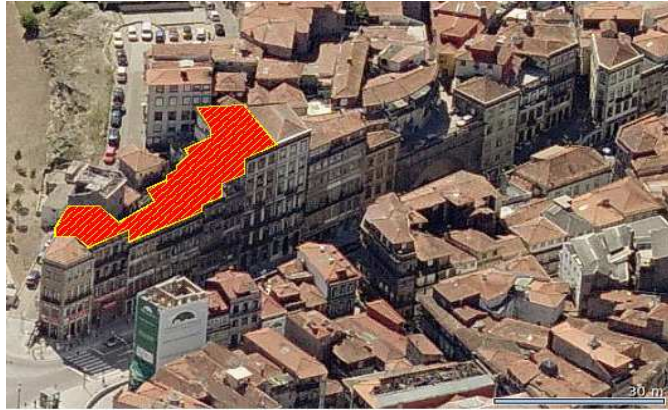
Figura 3.2 – Vista sobre o Quarteirão do Corpo da Guarda, com a indicação da localização dos edifícios em estudo, ( http://www.bing.com/maps/ ).
