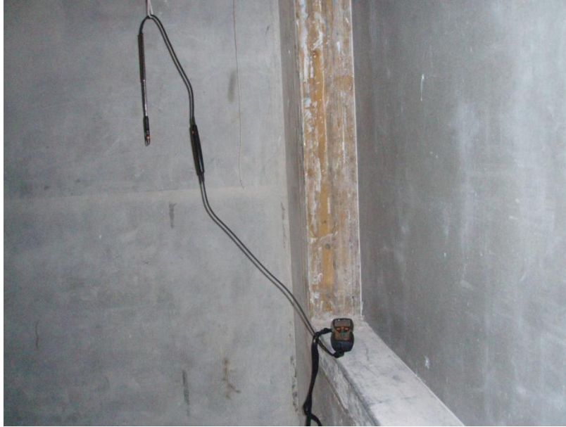
Figura B.1 - Fotografia do Termo – Higrómetro utilizado durante os ensaios.
