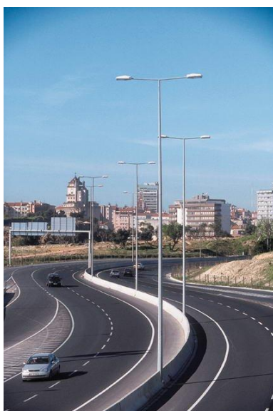
Figura 4.15 - Luminárias instaladas em Lisboa [20]
