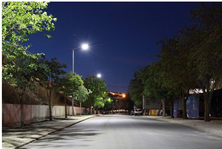
Figura 4.40 - Luminárias a LED instaladas na Rua Fidalgo Aprendiz, Pombal [47]
