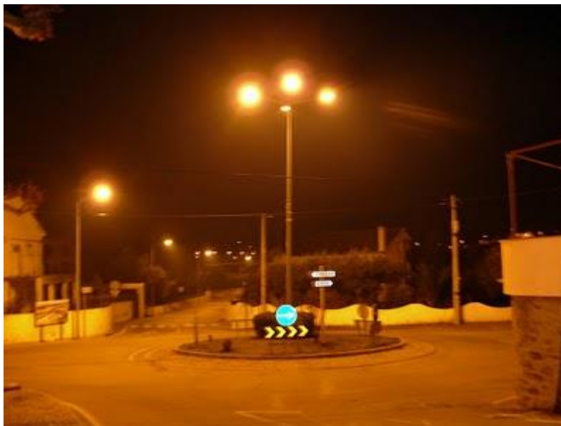
Figura 4.24 - Luminárias instaladas em Peso, Covilhã [38]
