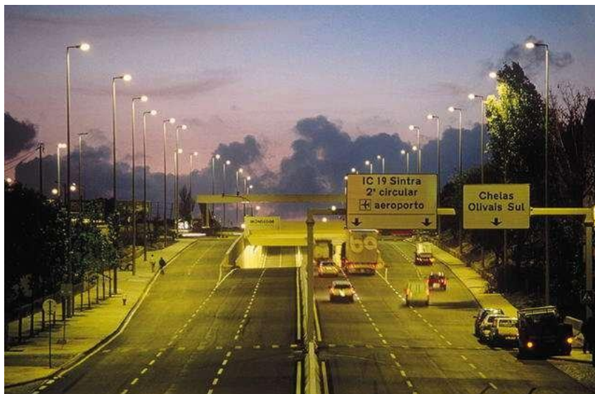
Figura 4.20 - Luminárias instaladas em Lisboa [20]
