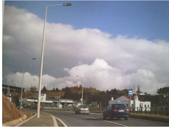
Figura 4.17 - Luminárias instaladas em Cascais [20]
