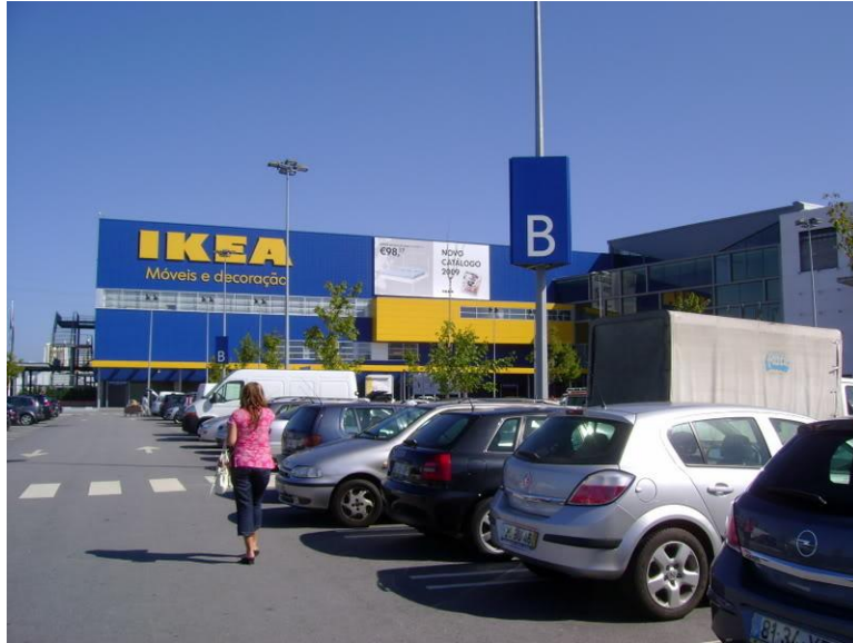
Figura 4.26 - Luminárias instaladas em Matosinhos (parque exterior do Mar Shopping) [39]
