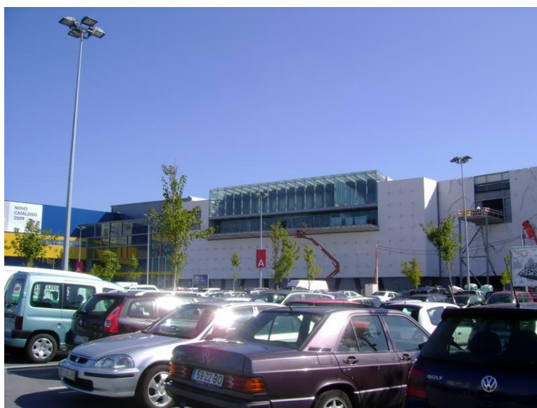
Figura 4.25 - Luminárias instaladas em Matosinhos (parque exterior do Mar Shopping) [39]
