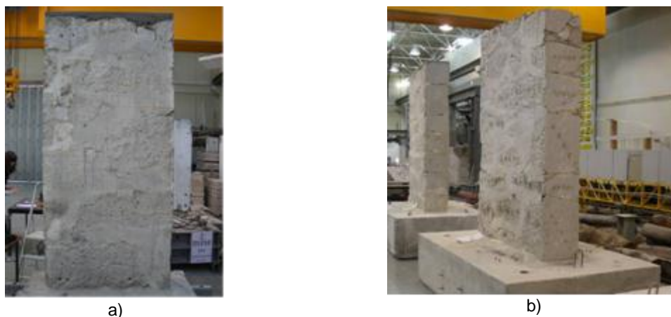
Figura 4.14 – Parede testada: a) painel de menores dimensões; b) painel de maiores dimensões.
