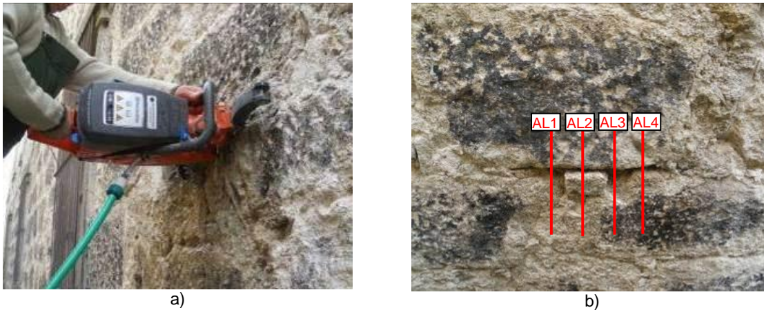
Figura 6.3 – Execução do ensaio no local MP2: a) execução de um corte; b) aspecto final do primeiro corte.
