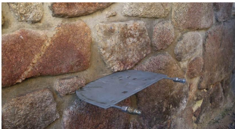
Figura 5.1 – Colocação do macaco plano numa parede de alvenaria.
