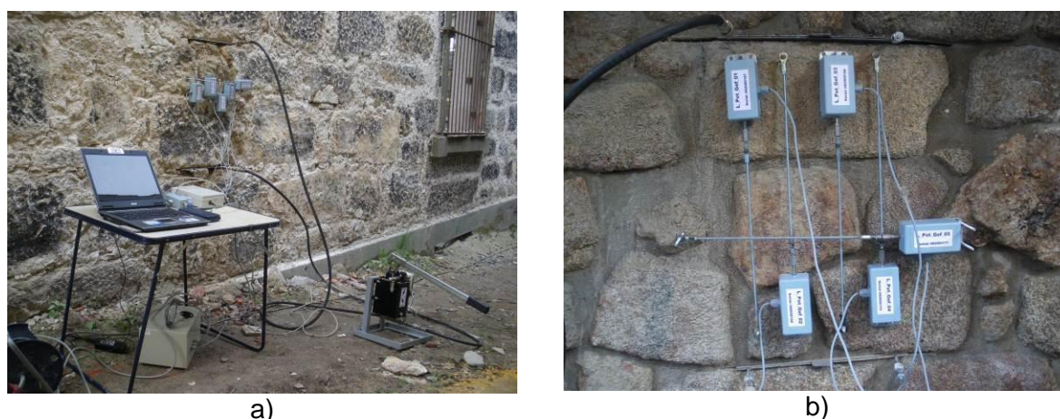
Figura 5.9 – Material utilizado num ensaio duplo: a) conjunto dos aparelhos utilizados; b) pormenor do local do ensaio.
