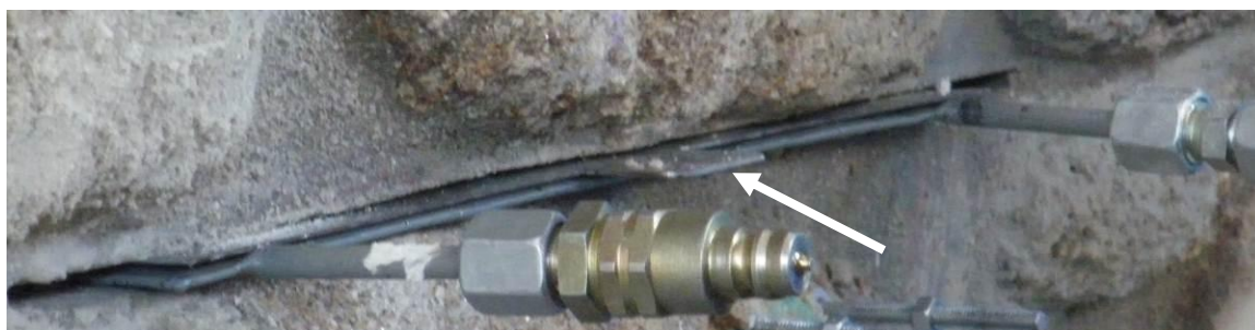
Figura 6.23 – Chapa de protecção colocada sobre a face superior do macaco plano.
