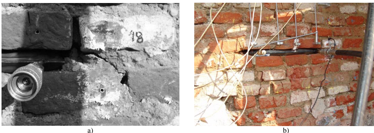
Figura 5.13 – Aspecto da alvenaria no final do teste: a) abertura de fendas junto ao macaco plano inferior; b) aspecto da alvenaria na zona subjacente ao macaco plano inferior (Acito, et al., 2008).
