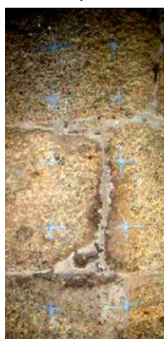
Figura 4.32 – Preparação de um ensaio num elemento com 1.2m de espessura (6x2 pontos).
