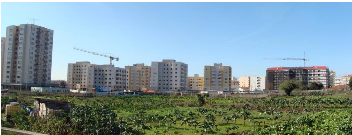
Imagem 11 – Vista da área a ser construída próxima ao conjunto da Cidade Cooperativa da Prelada no fundo do campo de cultivo. Porto, 2008
