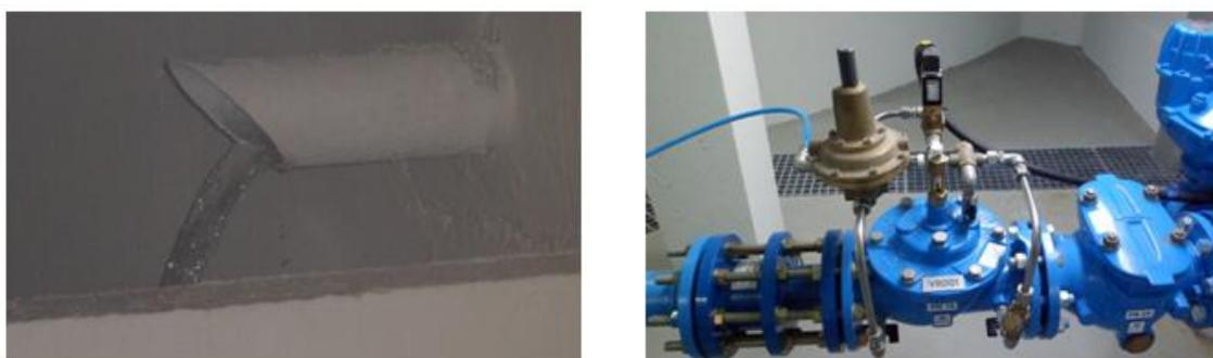
Fig 3.3. – Conduta de admissão de água em Aborim/Tamel (à esquerda); Válvula altimétrica (à direita).
