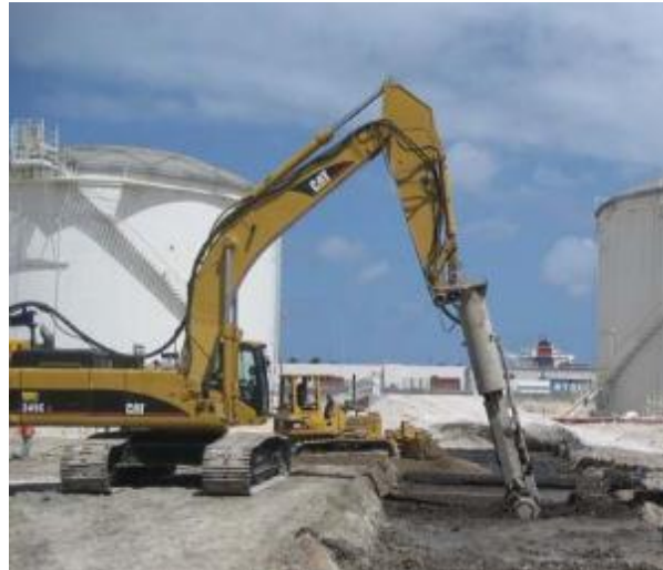
Figura 2.25 – Equipamento utilizado (Hayward Baker)
