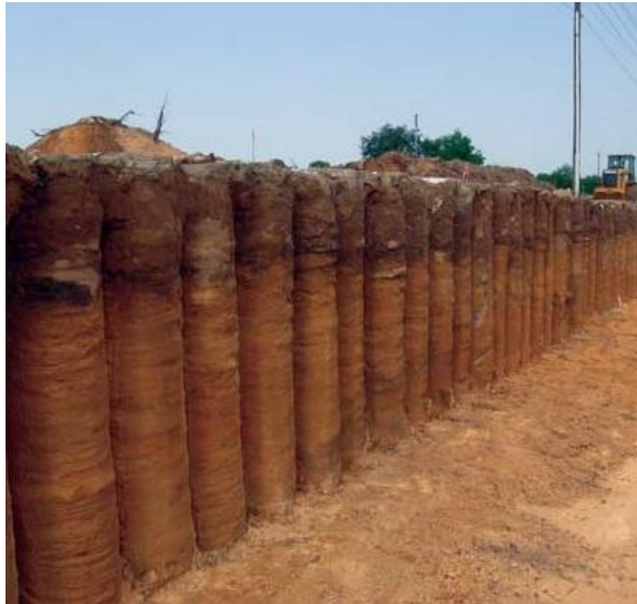
Figura 2.4 – Aspeto de um muro de contenção de terras em DSM (Hayward Baker)
