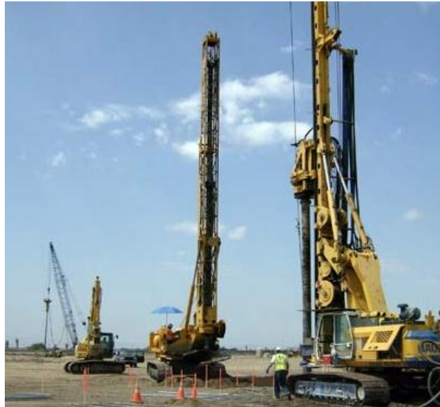
Figura 2.12 – Vista geral dos equipamentos em obra (Hayward Baker)
