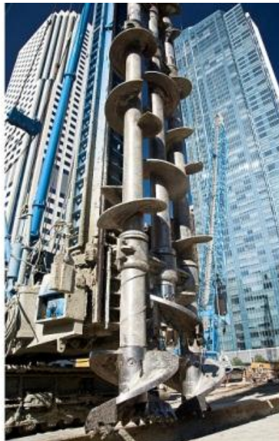
Figura 2.18 – Equipamento utilizado para a execução de colunas secantes de WMM (Malcolm Drilling)
