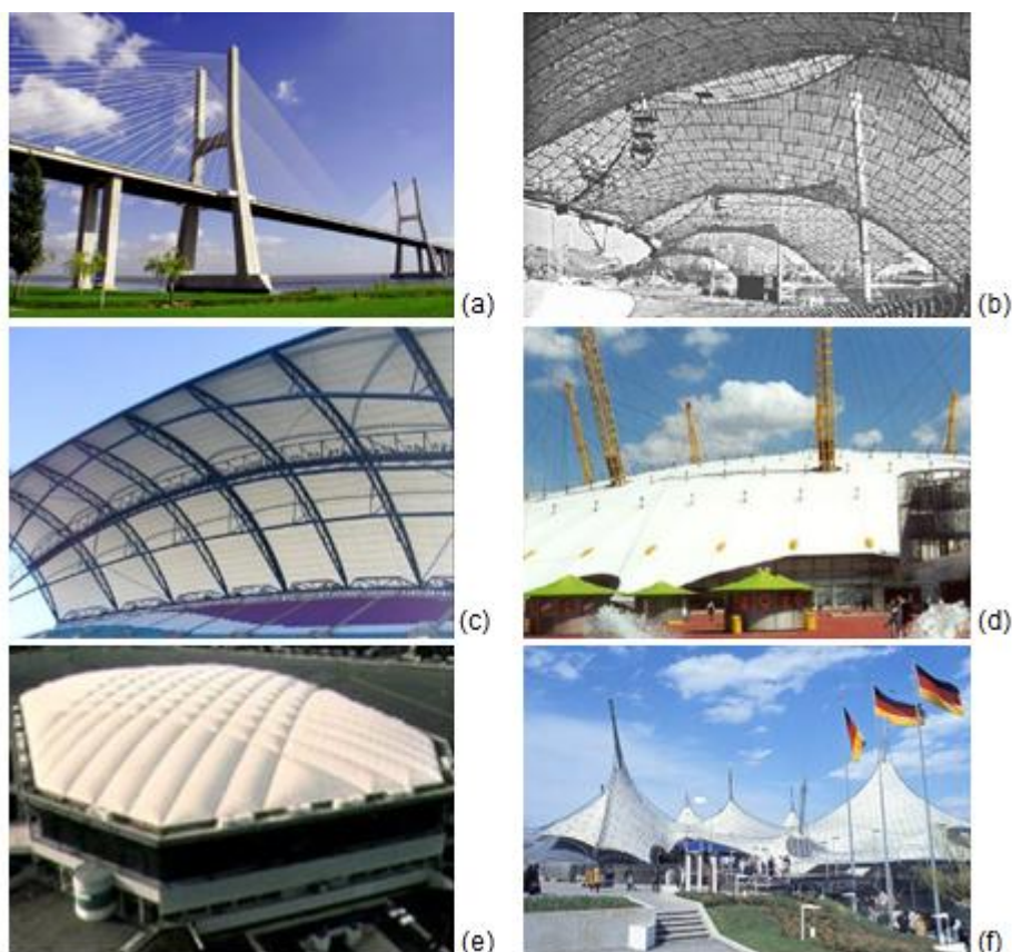
Fig. 1.1 – Estruturas tensionadas: (a)-Ponte Vasco da Gama 1 ; (b) -Estádio Olímpico de Munique 2 ; (c) – Estádio Faro-Loulé; (d) –Millennium Dome; (e) - Pontiac Silver Dome; (f) - Pavilhão alemão da Expo 67 3 .
