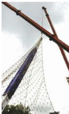
Fig. 6.32 – Içamento de uma estrutura de cabos com mastro
