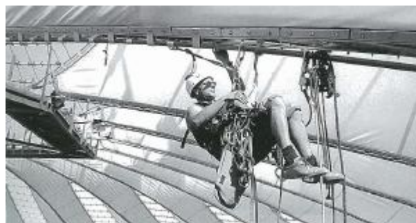
Fig. 2.68 – Ligação das placas metálicas do bordo da membrana aos cordões externos através de voltas metálicas (Sony Center, Berlim, Alemanha)
