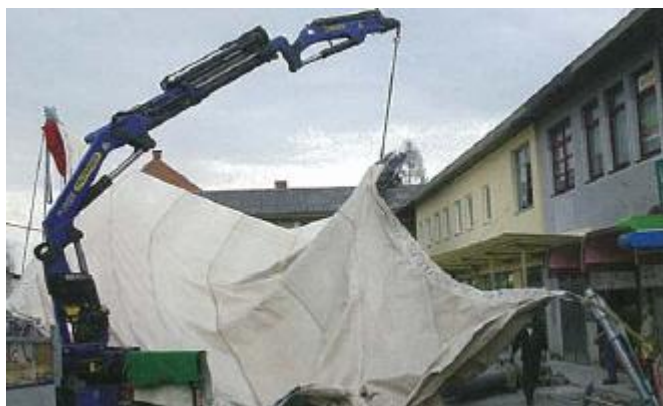
Fig. 6.30 – Içamento da estrutura
