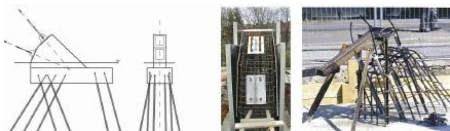
Fig. 2.21 – Construção de ancoragens elevadas para cabos estáticos
