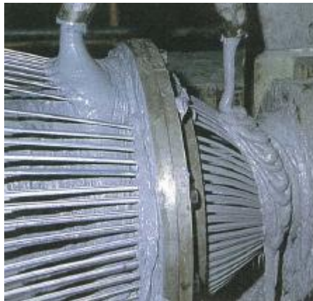
Fig. 2.11 – Colocação de material de preenchimento para protecção interior dos cordões
