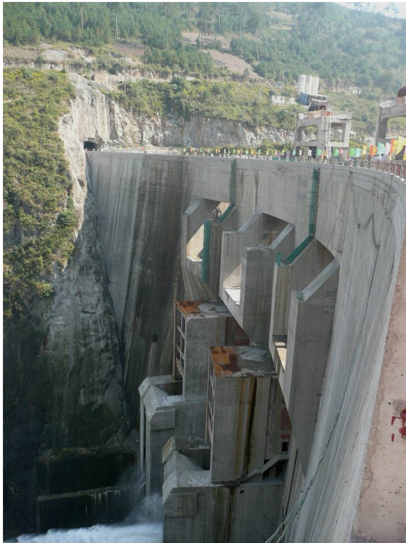
Figura 26 – Paramento de jusante da barragem de Dahuashui
