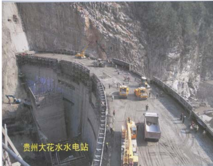
Figura 15 – Barragem abóbada em BCC (“Warm Arch”)
