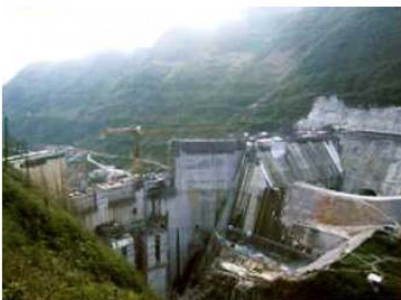
Novembro de 2006 conclusão dos trabalhos em BCC
