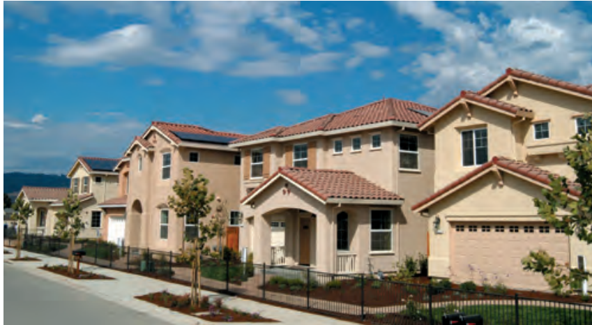
Figura 4.13 - Vista Montaña Zero Energy Community em Watsonville [37].
