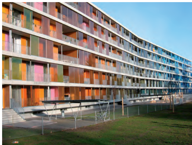
Figura 4.11 - Edifício desenvolvido de acordo com a MINERGIE em Brunnenhof [37].
