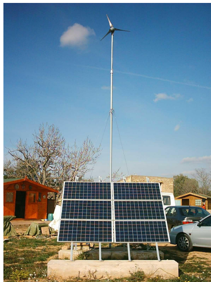
Figura 5.4 - Sistema híbrido instalado em Miami [61].
