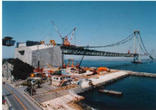
Figura 2.1.: Ponte Akashi-Kaikyo (Japão)
