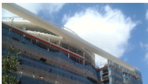
Figura 2.4.: Viga de edifício do Alto Parque (Portugal)
