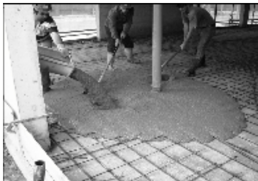
Figura 2.5.: Reforço de uma laje (Portugal)
