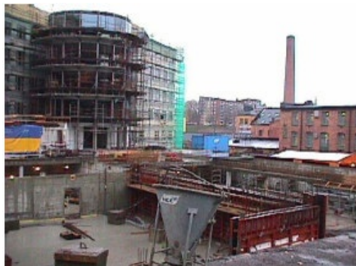
Figura 2.2.: Edifício habitacional (Suécia)
