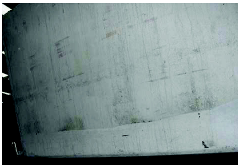
Figura 3.7.: Vista da parte lateral da peça betonada onde é visível a junta de betonagem
