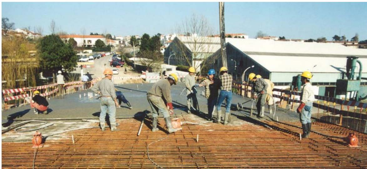
Figura 2.1 – Aspecto geral de uma betonagem com betão convencional
