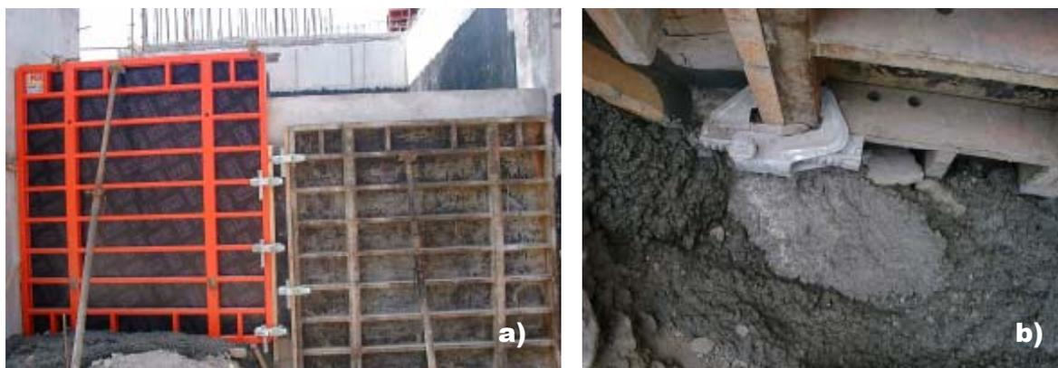
Figura 6.33 – Aspecto da cofragem no muro betonado e a falta de estanqueidade da mesma permitindo a fuga de alguma material
