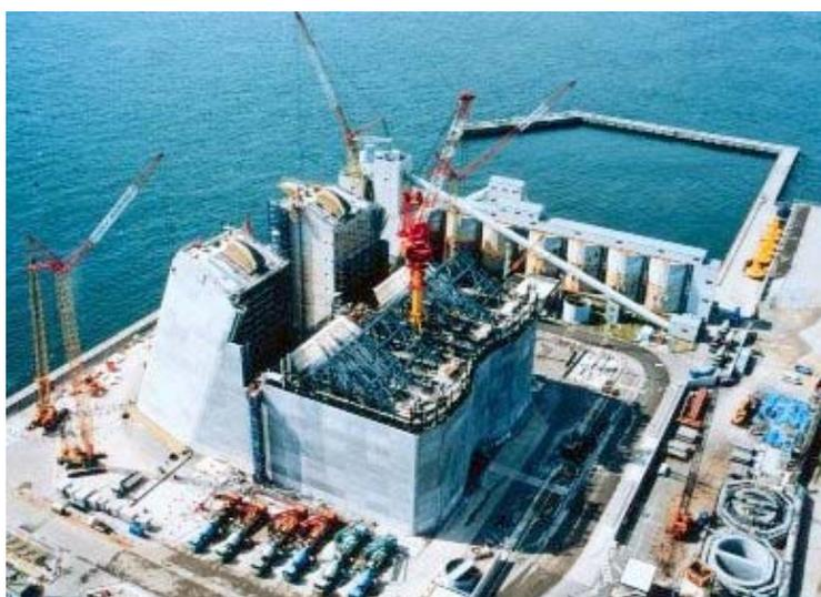
Figura 2.3 – Betonagem de uma das ancoragens da ponte de “Akashi Kaikyo”
