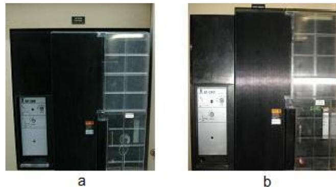
Figura 2.4 - Disjuntor de protecção do transformador (a) e Interbarras (b)
