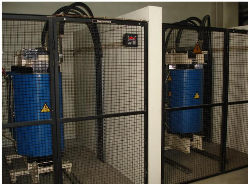
Figura 2.2 - Transformadores 1 e 2 do Posto de Transformação
